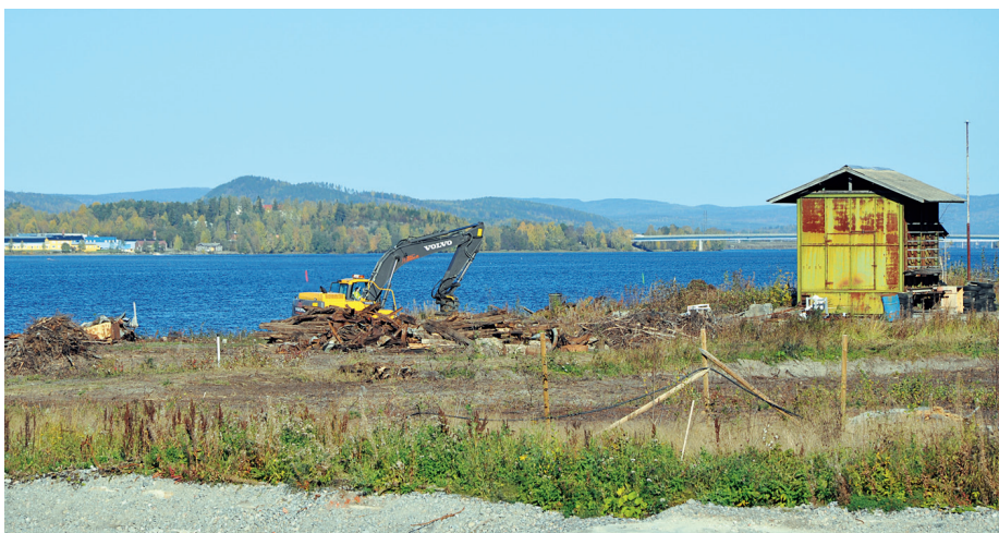
Stubbar, rötter och andra trärester går till förbränning i Timrå. De mest förorenade massorna transporteras till Sakabs förbränningsanläggning i Kumla.
