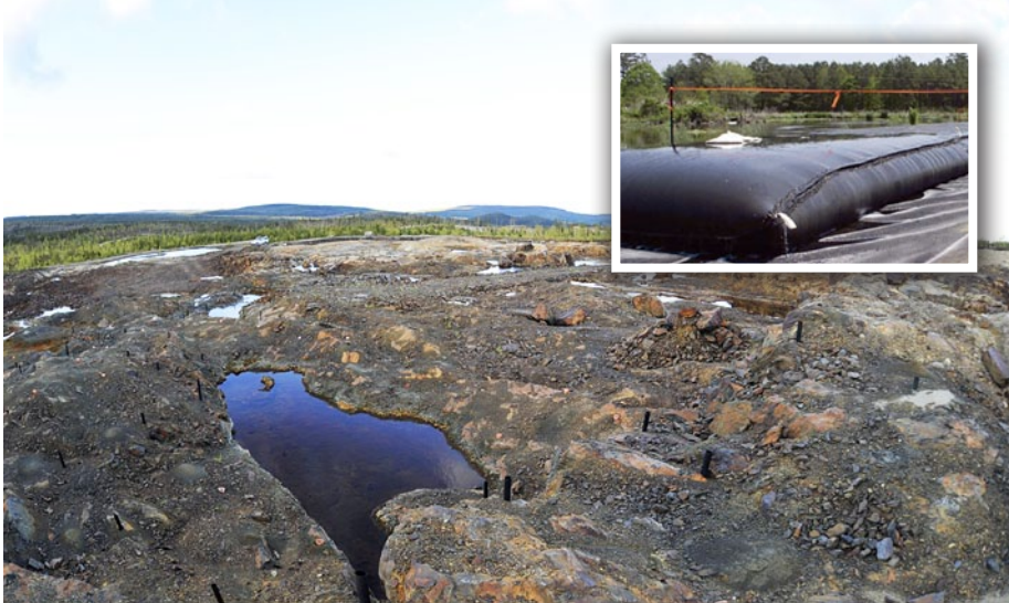
Här ska avvattningsytan anläggas i form av 14 terrasser. Geotuberna (lilla bilden) är som stora säckar i textilt material med små hål där det rena vattnet kan rinna ut.
