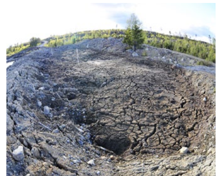
Slam har lagts innanför en invallning intill dammen för att ge utrymme för nytt slam i dammen.
