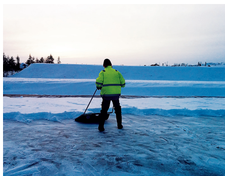
Under vintern har geotuberna skottats för att underlätta frysning.
