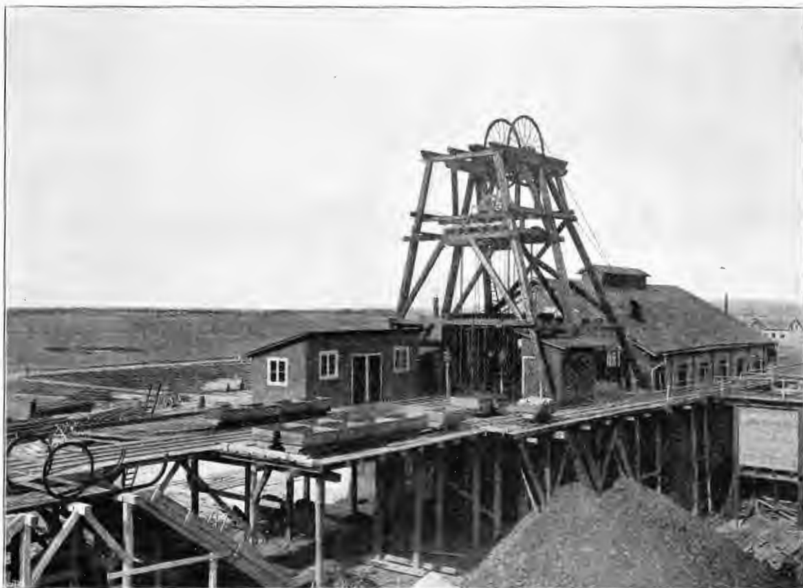
Fig. 235. Hyllinge schakt N:o I: Transportbryggan med grufvagnar, hissgalgen och (till höger) maskinhuset.
