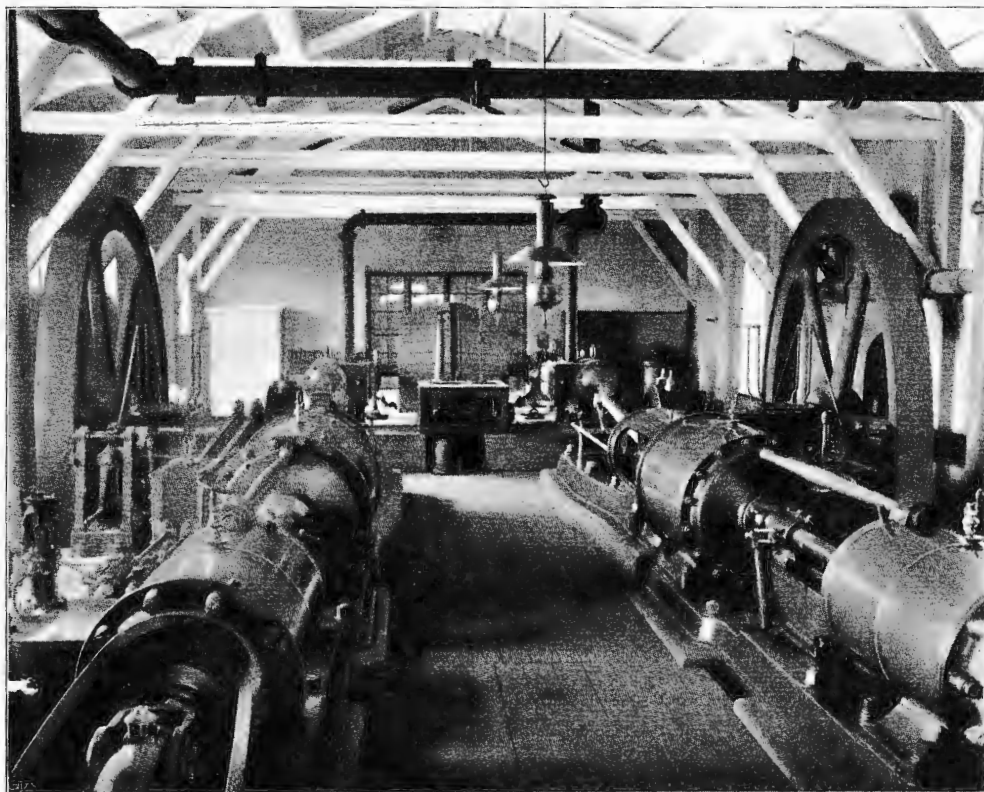
Fig. 101. Maskinrum med uppfodrings- och pumphmaskinerna vid schaktet Prins Gustaf Adolf, Höganäs. (Byggnaden är belägen mellan uppfodringsgalgen och pumphschakttornet, se fig. 102.)
