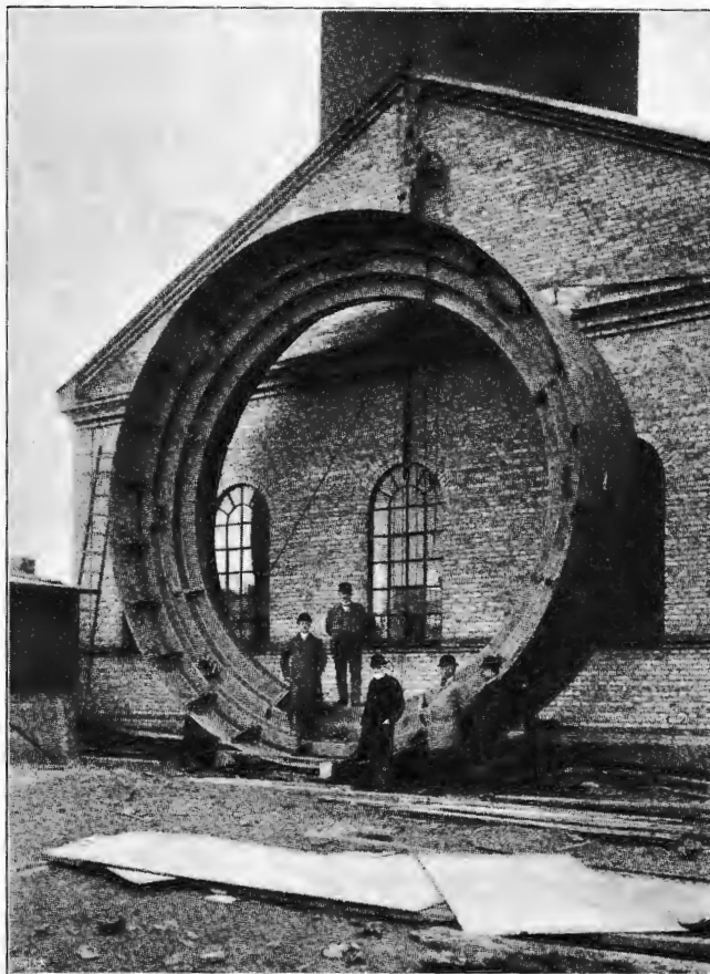
Fig. 263. »Sänkskon» för schaktet Carl Cervin, Ormastorp. Yttre diameter 7,65 meter. Efter en af I. SVEDBERG erhållen fotografi. — Af personerna äro den förste och den tredje från vänster räknadt Öfveringenjörerna I. SVEDBERG och E. ULFFERS.
