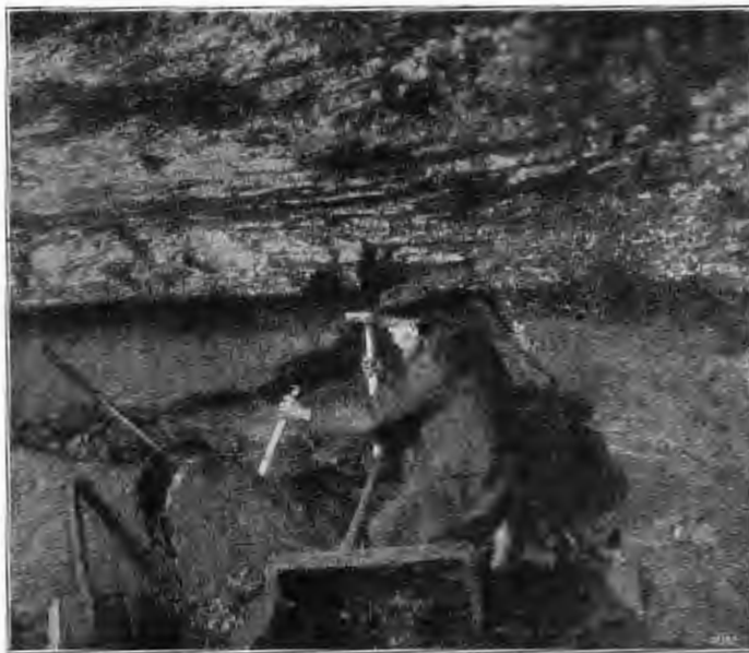
Fig. 199. Väggen i brottet i en s. k. lerort; nedre flötsen vid Bjuf. Foto af M. SVANBERG. Mannen kilar sönder ett nedsprängt stycke sandsten.
