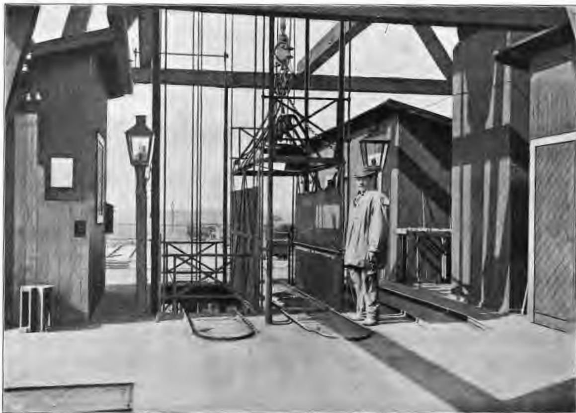
Fig. 237. Hyllinge schakt vid mynningen (»på lafven», »på gamsen»). Fotografi af M. SVANBERG 1903. Den ena hisskorgen är uppe. Mannen där bredvid är öfverfogden LUNDQVIST. I bakgrunden synos lastbryggan med grufvagnar.
