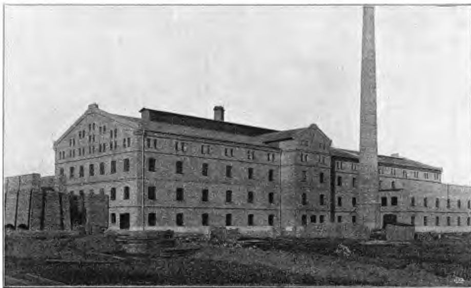
Fig. 95. Klinkerfabriken I vid Hyllinge. Till vänster gasgeneratorer. Efter fotografi af Ingeniör M. SVANBERG.
