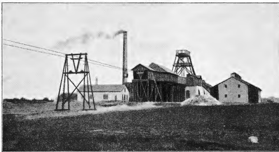
Fig. 217. Schaktet Konsul vid Skromberga, med den därifrån utgående linbanan. Från sydväst.
