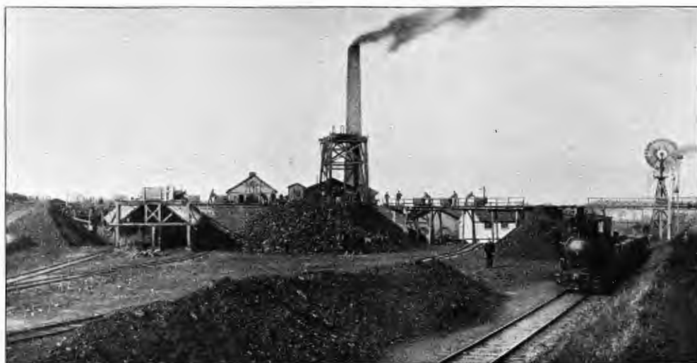
Fig. 100. Schaktet Kung Oscar II vid Höganäs.
