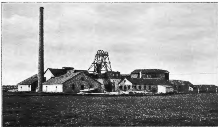
Fig. 216. Schaktet Sjöcrona vid Skromberga, sedt från söder.
