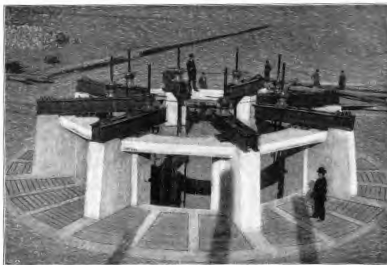
Fig. 263. Schaktet Carl Cervin, Ormatorp. Anordningarna i dagen vid schaktets afsänkning. Efter af I. SVEDBERG erhållen fotografi.
