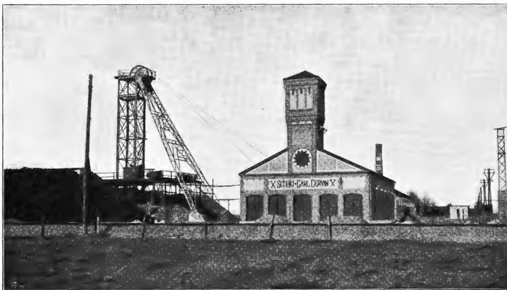
Fig. 259. Schaktet Carl Cervin (hissgalgen och maskinhuset) vid Ormastorp.
