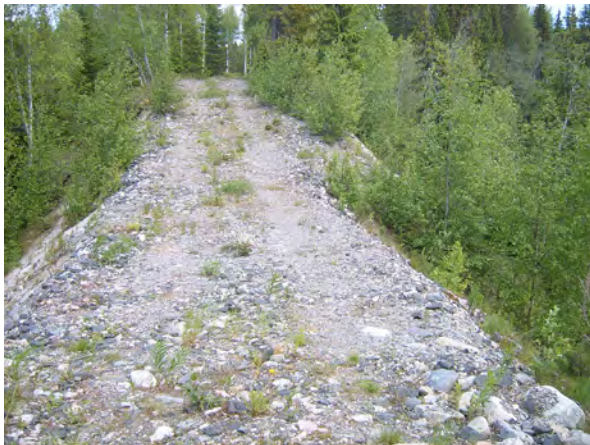
Figur 21. Vägen ut till Gropnåset har förstärkts i ett försök att förhindra att landtungan skärs av. Foto: Mikael Berglund.
