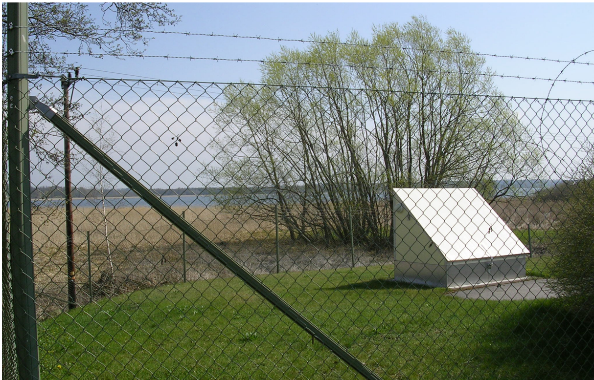
Fig. 2. En av råvattenbrunnarna i reservvattentäkten invid Fysingen. Foto: Magdalena Thorsbrink.
