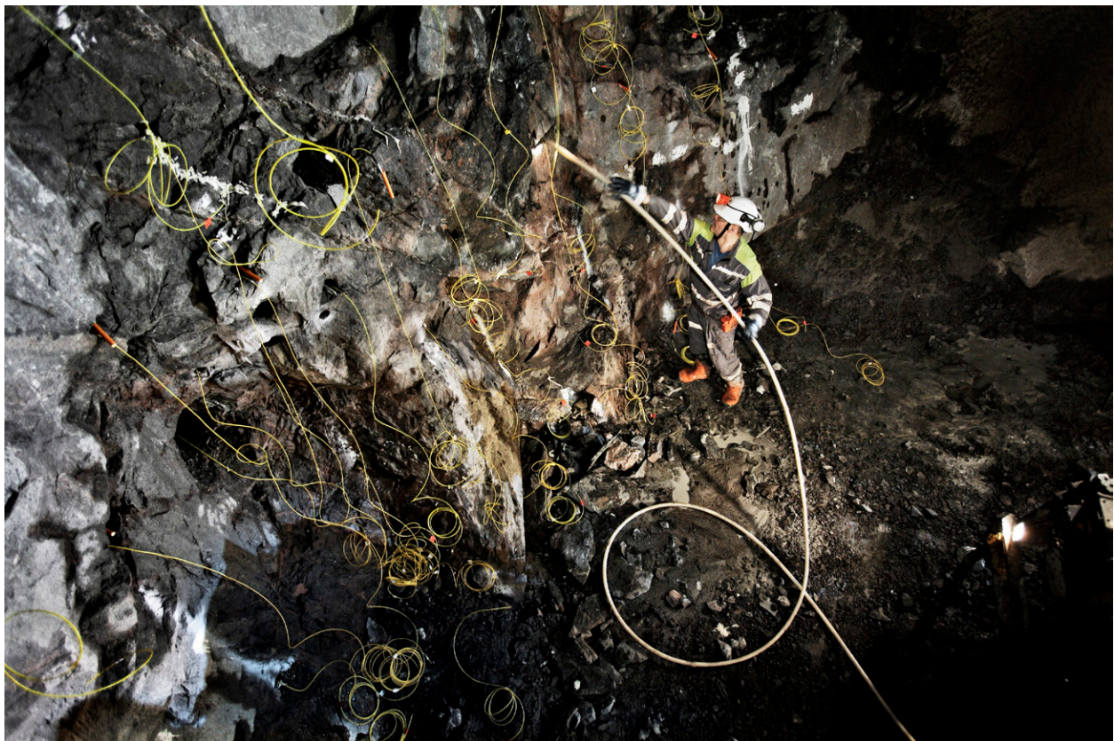
Laddning för ortdrivning i Kirunagruvan. Foto: Fredric Alm, LKAB
