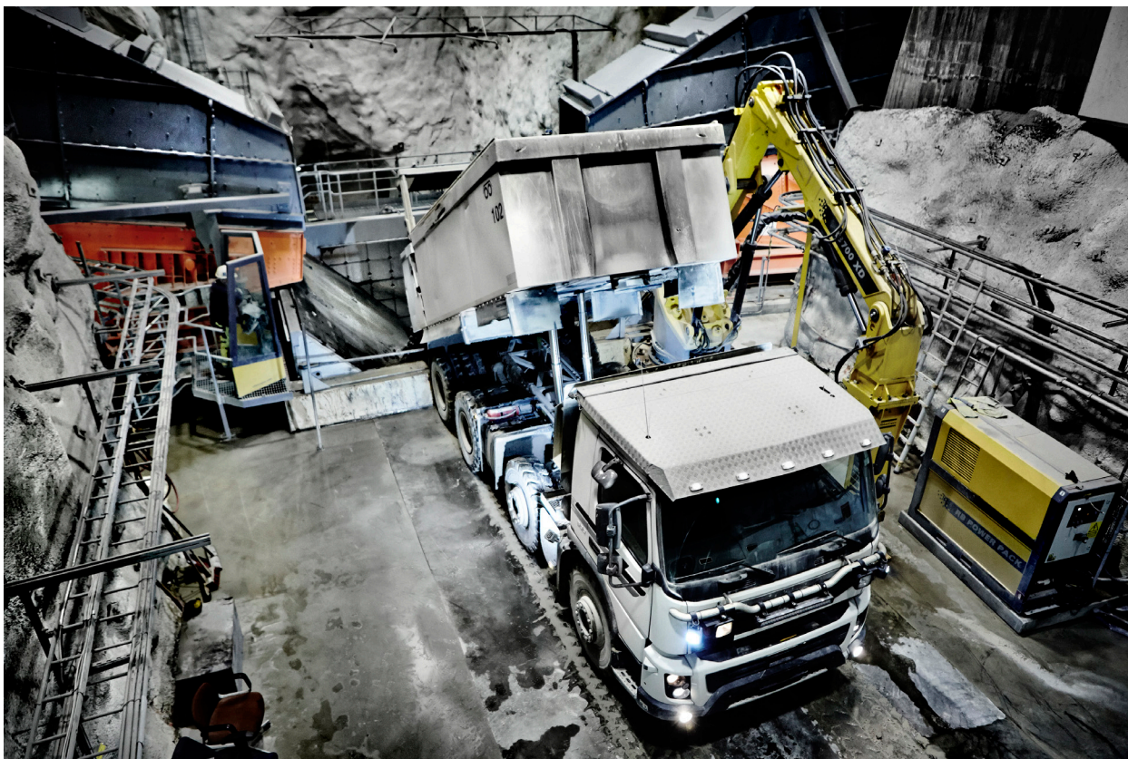
Nya underjordiska anläggningar i Garpenbergsgruvan. Foto: Stefan Berg, Boliden AB.
