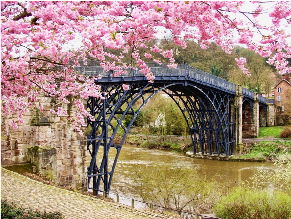
Bron över Ironbridge Gorge i England är den första större järnkonstruktion som byggdes. Källa: Pixabay.
