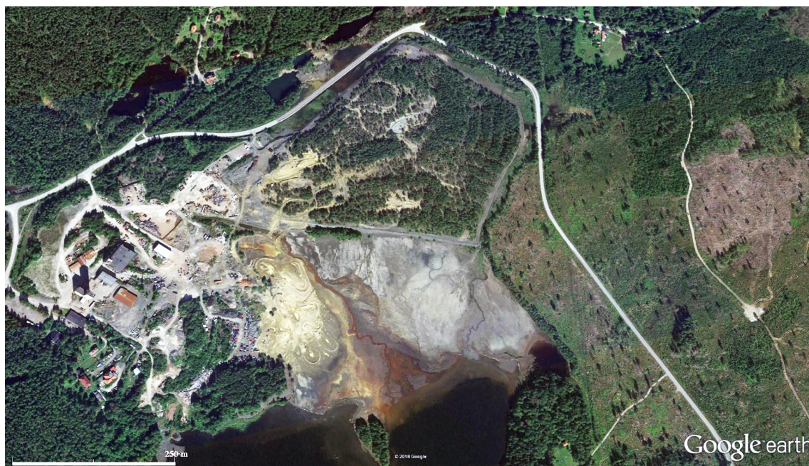
Figur 8. Översiktsbild av Bäckegruvan i Riddarhyttfältet. Sandmagasinets två huvuddelar kan urskiljas: den norra invallade delen som huvudsakligen är täckt av skog och annan vegetation, samt den södra delen i anslutning till Nedra Skärsjön. Foto: Google Earth.
