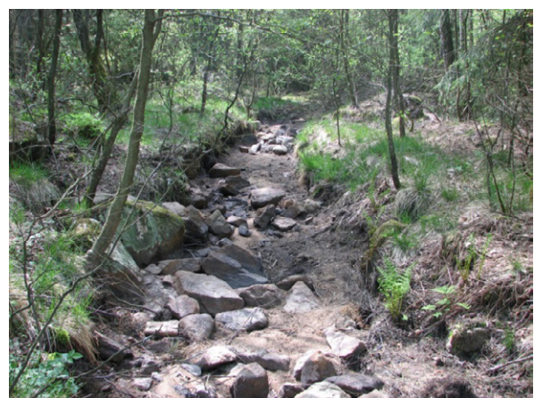
Figur 3. Uttorkat biflöde till Vadebäcken, Hallandsås, till följd av dräneringspåverkan från tunnelbygget.
