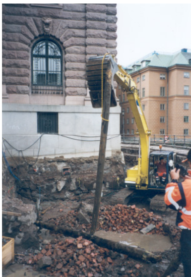
Figur 1. Grundpåle tas upp intill Riksdagshuset för att undersöka dess skick och nedbrytningsgrad. Foto: T. Nilsson.
