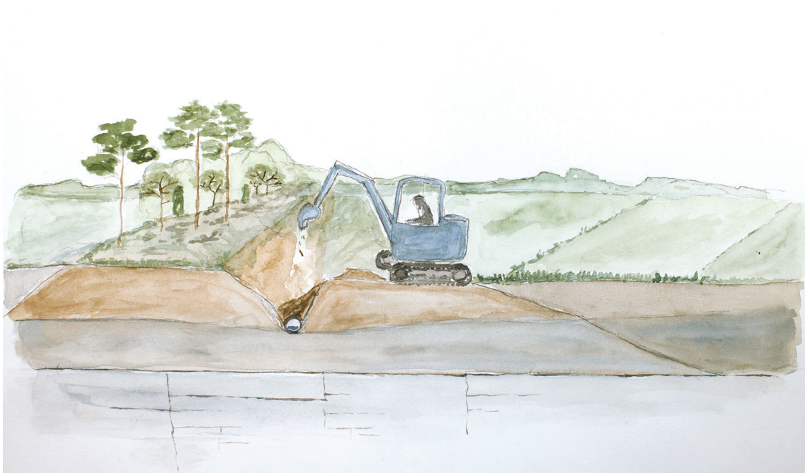
Figur 6. Kulvertering av dike. Grundvattenytan i dikets närområde höjs efter igenläggningen vilket leder till höjda grundvattennivåer och minskad lokal grundvattenbortledning. Dock bibehålls dikets avvattande effekt uppströms i de områden som diket avser avvattna.
