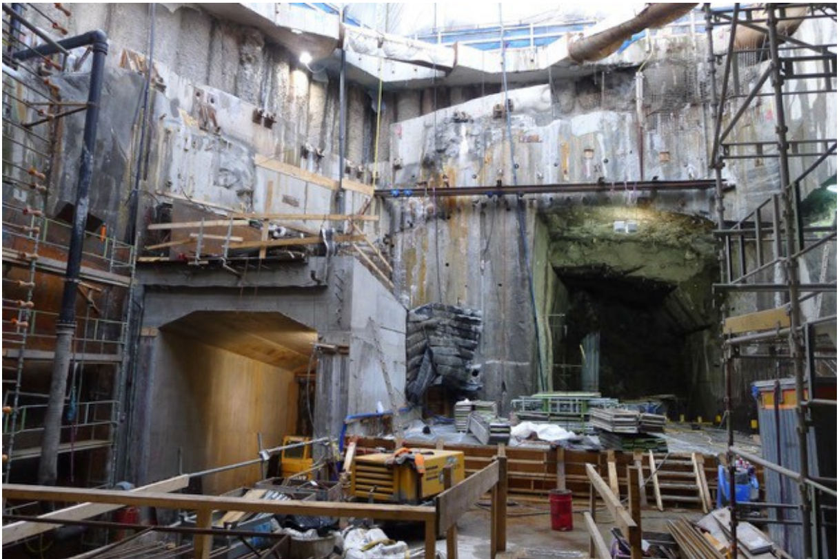
Figur 14. Riddarholmen. Schaktgrop i berg, avskärmad från Riddarfjärdens vatten med hjälp av sekantpåleväggar, som syns högst upp t.v. i fotot. Skonsamt berggutttag har utförts med wiresågning då bergtäckningen är liten. En sänka i bergytan ovan betongtunneln har fyllts med betong. Sänkan beror på en ca 1/2 m bred sprickzon (Figur 13), som stryker åt NV med stupning åt SV. Foto: Anja Olsson, Golder.
