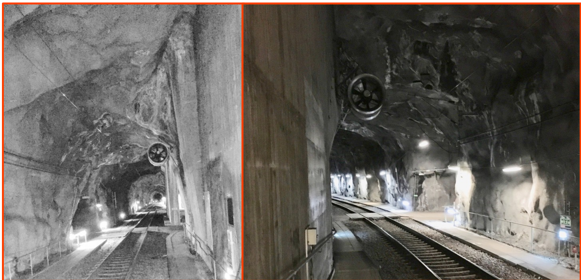
Figur 28. Arlandabanan, södra änden av station Arlanda N (terminal 5). Här förekom hävning i taket i samband med sprängning. Sprickan som uppstod mellan bergpelare och ovanliggande bergmassa syns inte på bilden då den är täckt av sprutbetong och den gjutna betongpelaren. Foto: Lars M Hansen.
