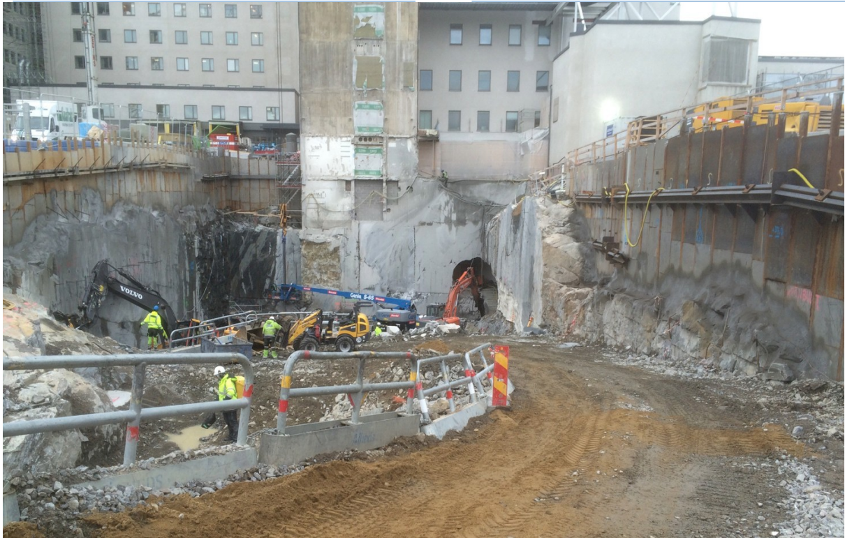
Figur 15. Södersjukhuset. Sågade, ca 10 m höga bergväggar intill befintliga byggnader. Innan sågning har det utförts förebyggande förstärkning i form av lång bult satta från krönet för planerad slänt. Foto: Jörgen Theander, Golder.
