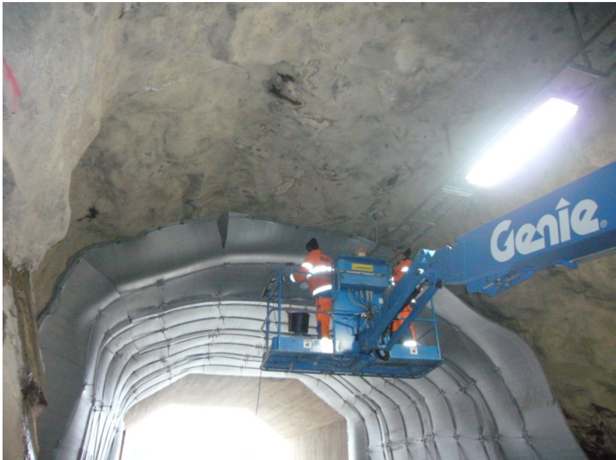
Figur 10. Skivor av extruderad polyeten i tak och väggar vid mynningen och en bit in i Finnbergstunneln.
