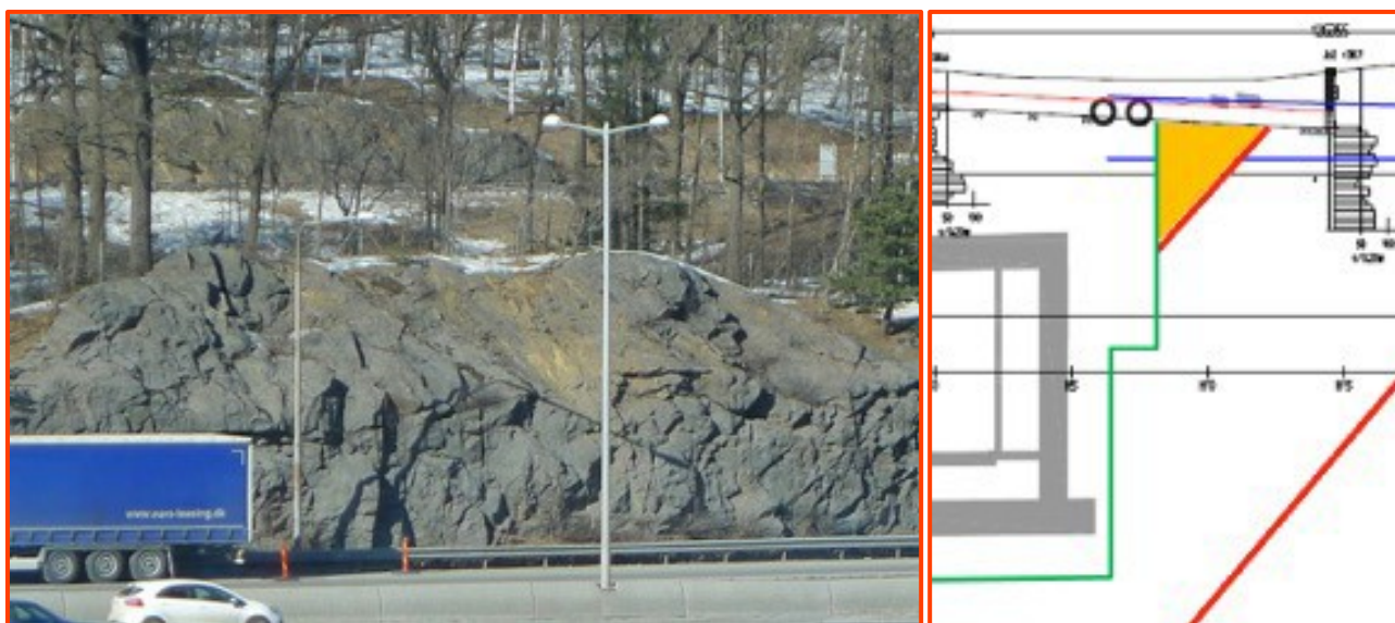
Figur 8. Bergskärning vid E4/E20 vid Kungens Kurva. Bergskärningen är ca 6 m hög. Konturhålen har borrats vertikalt, men på grund av utglidning har släntens lutning upptill blivit flack. Strukturens mynning högt upp på slänten medförde att utfallet blev begränsat. Den undre röda linjen i högra figuren visar en struktur som ligger tillräckligt långt från schakt för att bilda stöd för bergmassan. Foto: Lars M Hansen.
