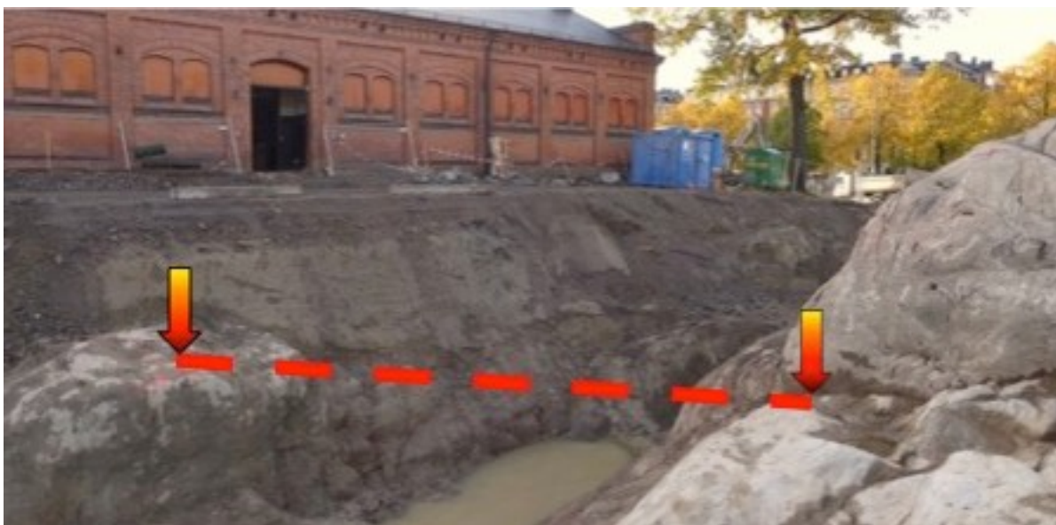
Figur 31. Exempel på hur bergsondering kan ge upphov till missvisande tolkning. Vid sondering som utförts vid pilarna (cc ca 10 m) missades sänkan. Foto: Edward Runslätt, Golder.
