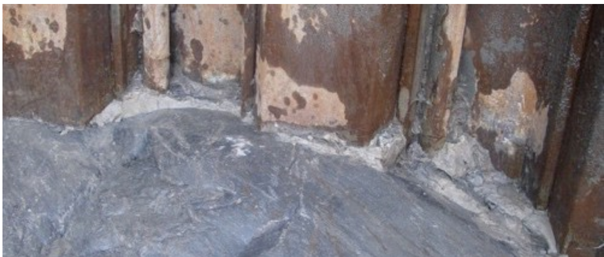
Figur 34. Injekteringsbruk i kontakten mellan spontfot och berg. Foto Mikael Creütz, Golder.
