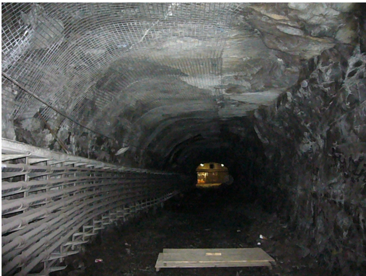
Figur 2. Ventilationstunnel vid Hälsingehöjden. Avskalningar av tunna bergskivor och även rena bergbrott bakom ett förstärkningsnät i taket.
