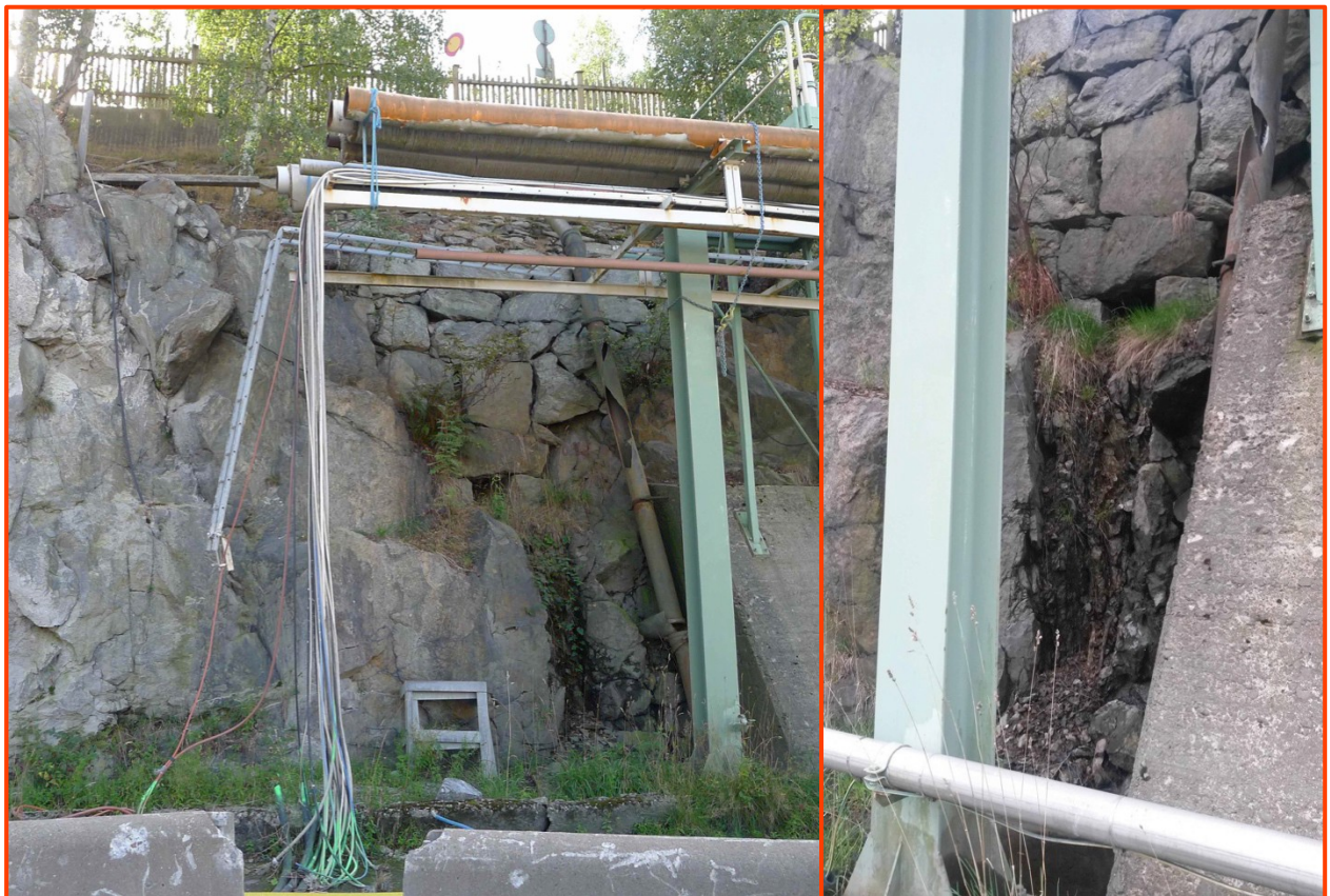
Figur 12. Hjorthagen. Sprickzon som även markerats på byggnadsgeologiska kartan. Översikt och närbild. Foto: Sofie Eskilander, Golder.
