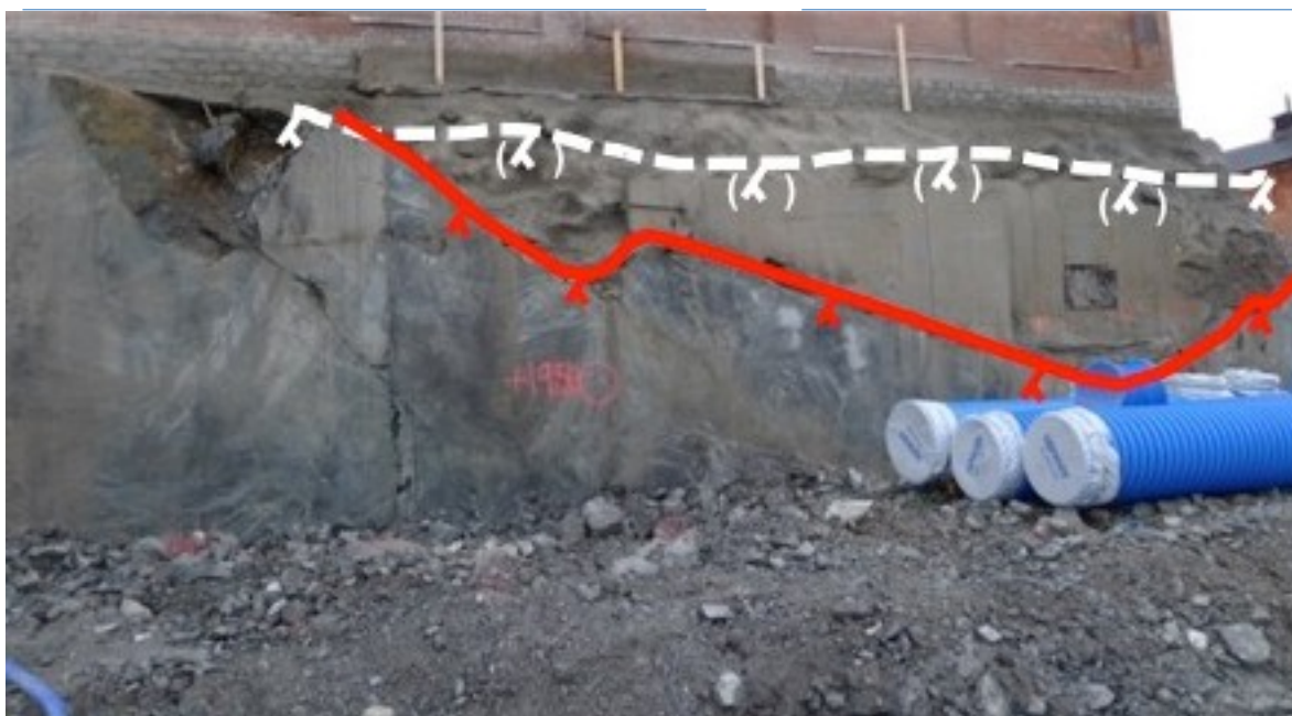
Figur 32. Figuren visar tolkad (vit) bergnivå baserad på sonderingar och verklig (röd) bergnivå, samt stödmur som fick byggas på grund av detta. Foto: Edward Runslätt, Golder.
