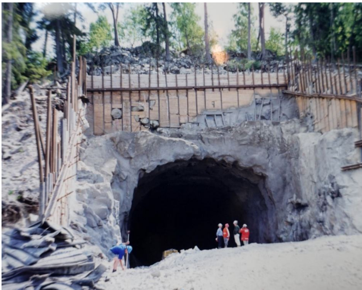
Figur 1. Tågtunnel för dubbelspår söder om Kungsängen. Blockig morän ovanpå kuperad bergyta.
