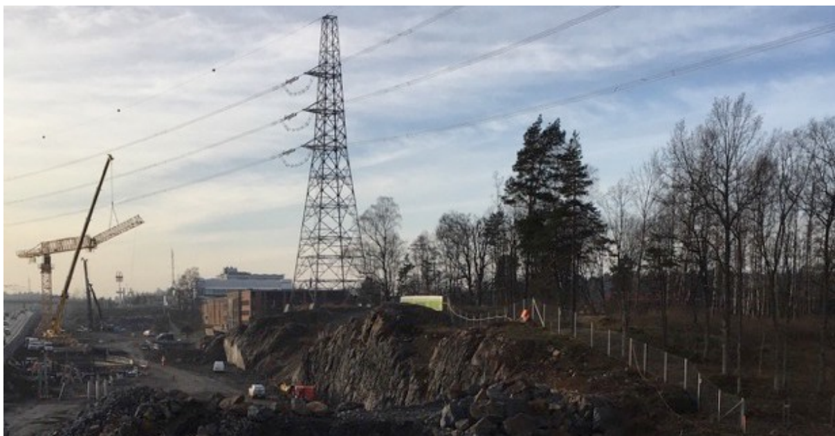
Figur 10. Samma kraftledningsmast som i Figur 9. Konturen flyttades några meter ifrån planerat läge och sågades i tre snitt. Ett av sågsnitten syns tydligt t. v. om masten. Foto: Lars M Hansen.
