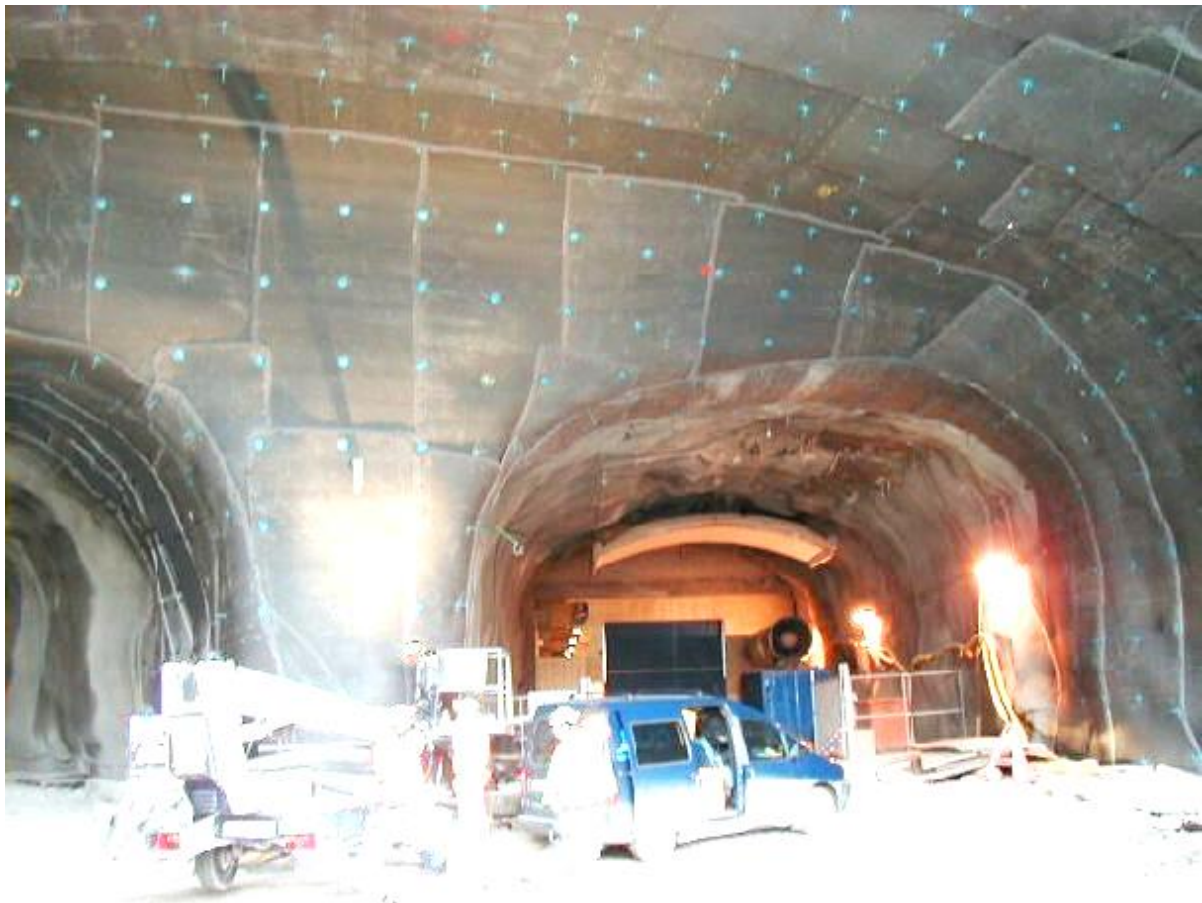
Figur 3. Så kallat Örstavalv i Södra länkentunneln.
