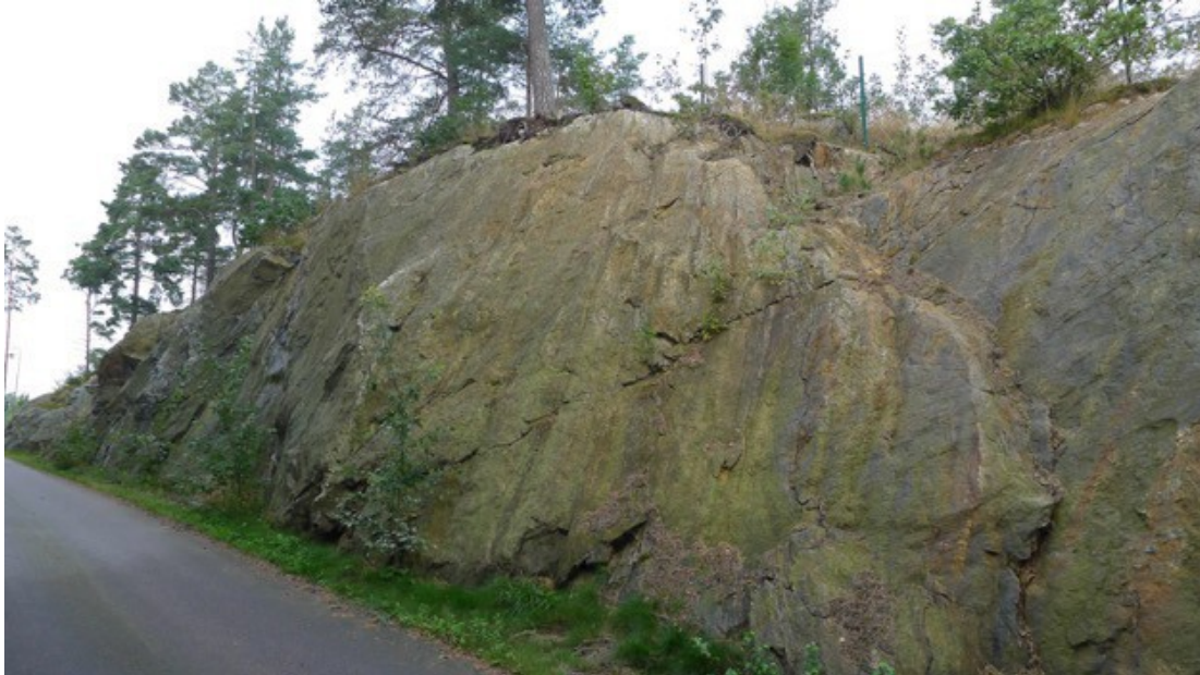
Figur 6. Bergskärning vid Smista Allé. Bergskärningen är ca 3 m hög. På grund av utglidning längs en foliationsyta har släntens lutning blivit flackare än den borrade konturen, som var vertikal. Den ringa höjden har medfört ett hanterbart utfall, och slänten är numera stabil då den följer den befintliga bergstrukturen. Foto: Lars Bergkvist, Golder.
