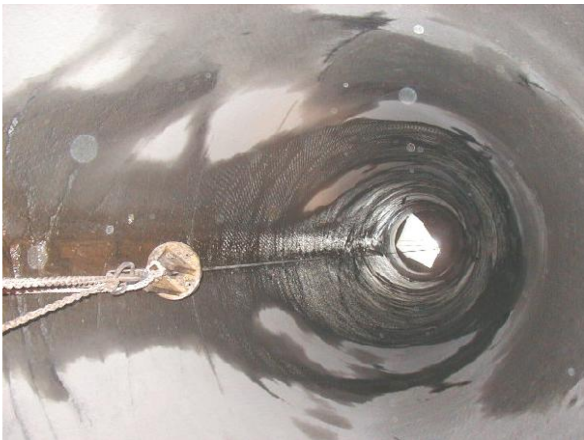
Figur 13. Raiseborrat ventilationsschakt.
