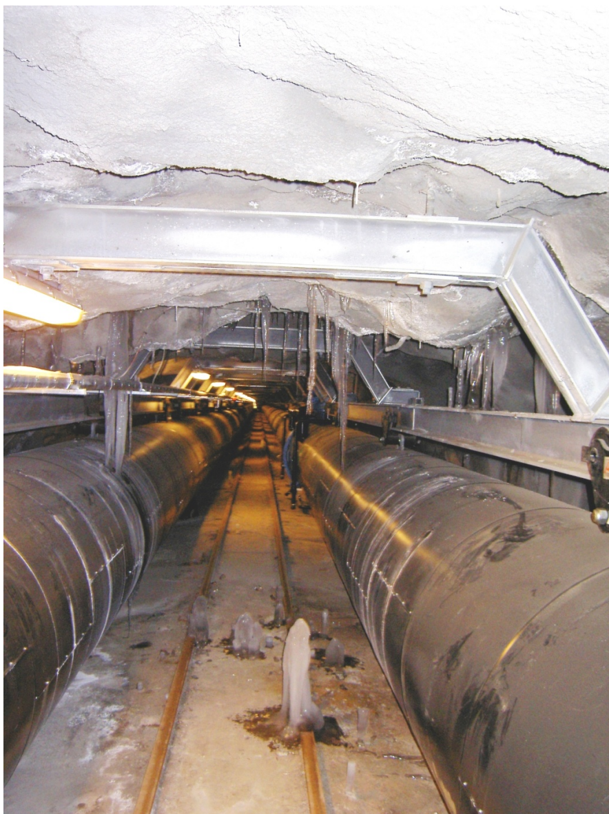
Figur 14. I tunneltaket upphängda tunga rör. Provdragning var nödvändig för att säkerställa hållfastheten.
