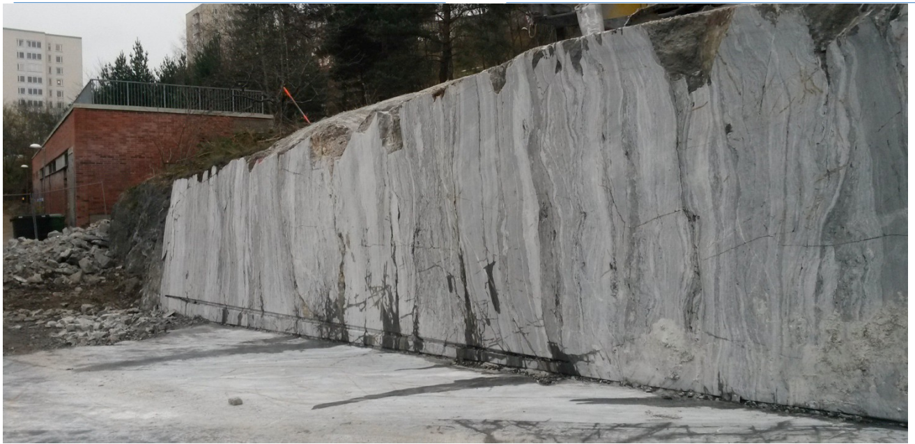
Figur 3. Liljeholmen. Wiresågad bergskärning med oregelbundna bankningssprickor och en brantstående gnejsighet/foliation. Skärningen ligger ovanför en befintlig tunnel, och både horisontell och vertikal bergskärning har wiresågats för att undvika att överskrida tillåtna vibrationsvärden i en hisstunnel. Foto: Anja Olsson, Golder.
