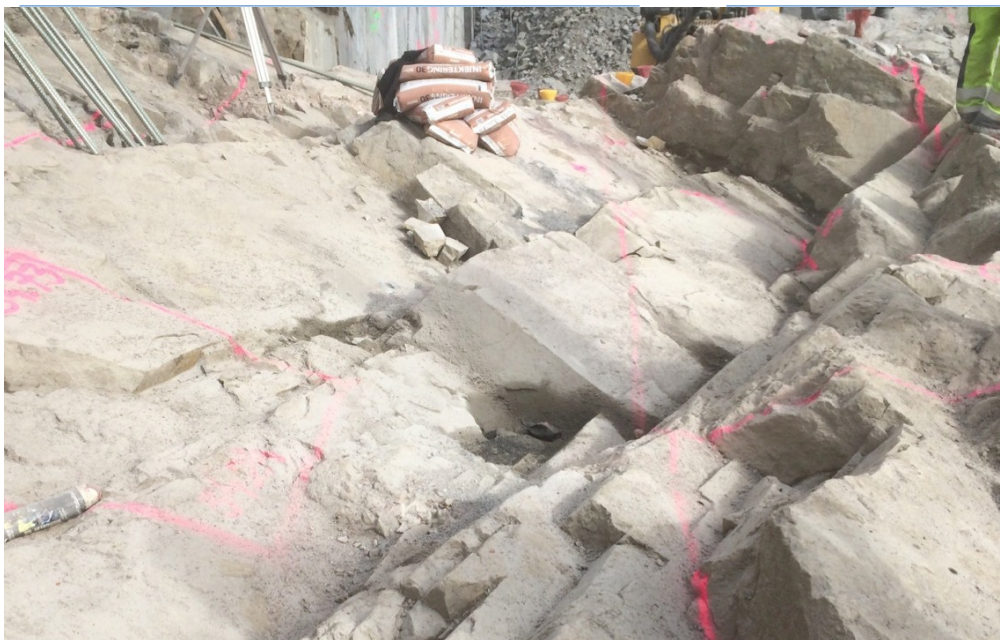
Figur 20. Sydligt stupande sprickor vid Södersjukhuset. Foto: Lars Bergkvist, Golder.
