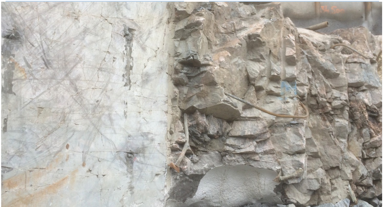
Jämförelse mellan sågad och sprängd bergmassa. Foto: Jörgen Theander, Golder.Ass.
