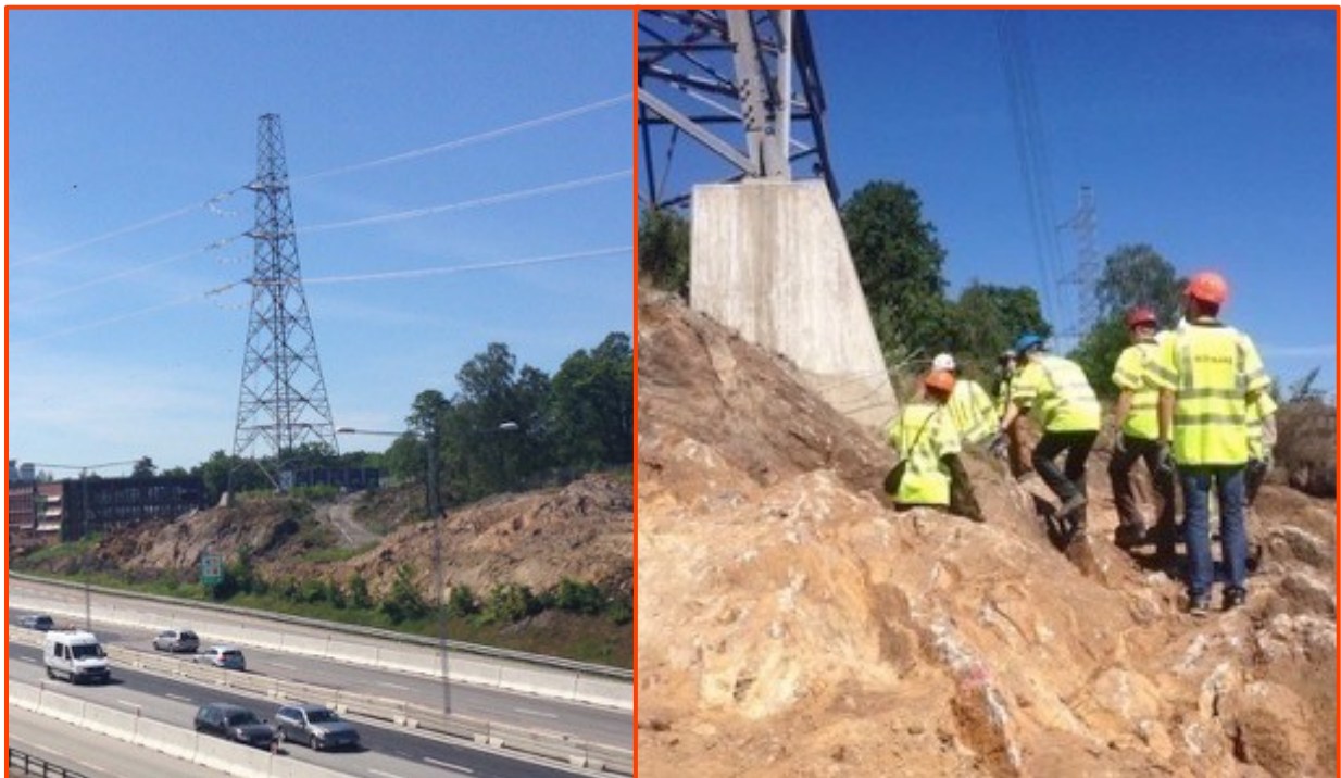
Figur 9. Kraftledningsmast nära väg som skall breddas. Bergmassan består av sedimentgnejs av mindre bra kvalitet och med oxiderade partier. Foto: Lars M Hansen.
