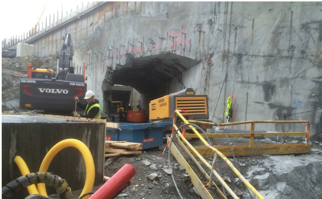
Figur 15. Södersjukhuset. Sågade, ca 10 m höga bergväggar intill befintliga byggnader. Innan sågning har det utförts förebyggande förstärkning i form av lång bult satta från krönet för planerad slänt. Foto: Jörgen Theander, Golder.
