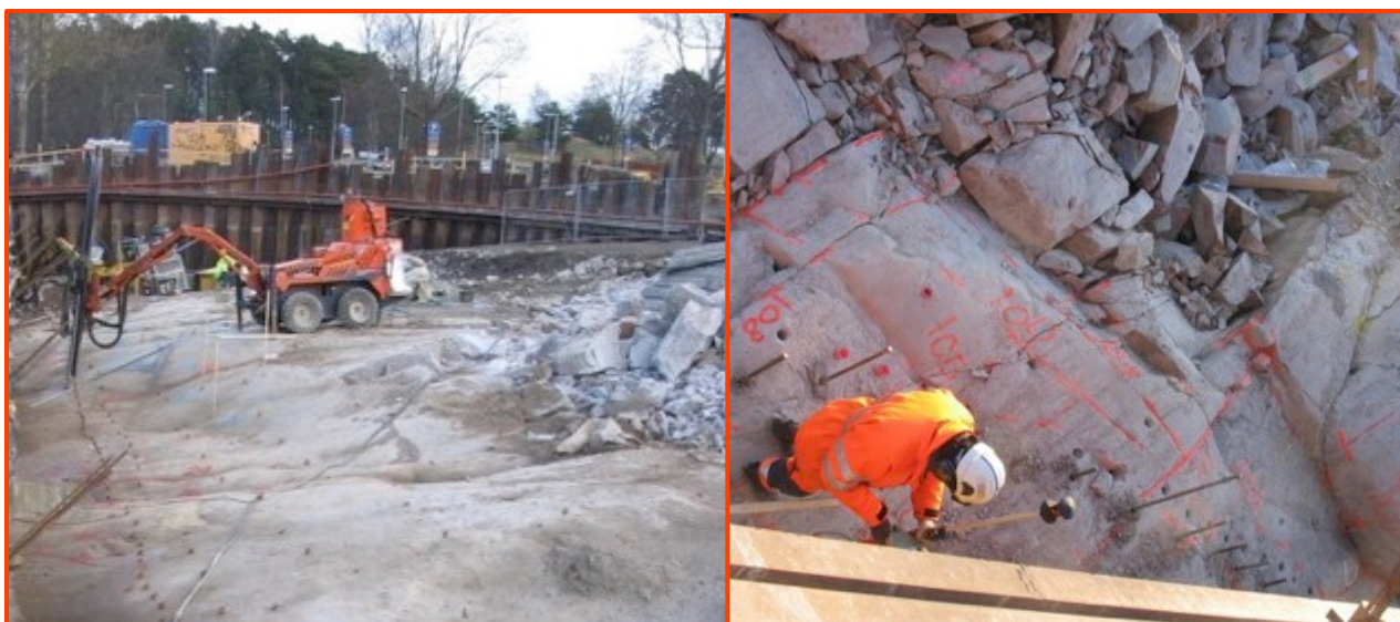
Figur 1. Täby. Vänster: borrning av konturhål intill spont. Höger: upptill syns ytberg skadat av spränggaser från en salva 4 m bort. Foto: Lars M Hansen, Golder.
