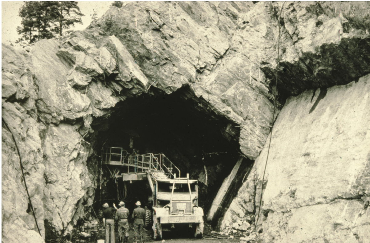
Medelbrant lutande sprickplan vid bygget av en avisningsanläggning i Älvsjö.
