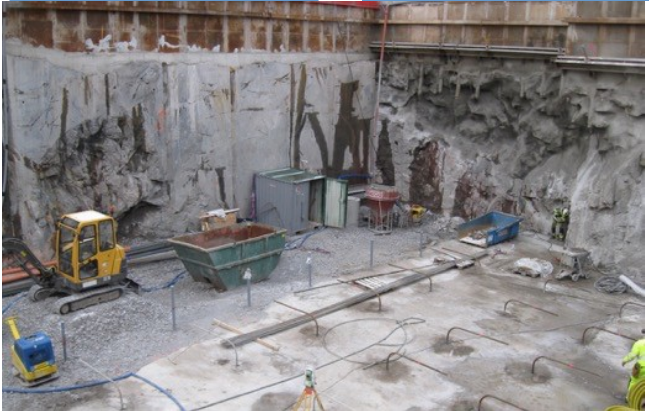
Figur 35. Grop av rörspont bestående av foderrör och svetsad plåt, där bergväggen till vänster har sågats med wire och den till höger har sprängts. Under spontfoten (mörka området till höger om mitten, där foderrörens undre ände hänger fritt) har block glidit ut, en utglidning av samma typ som visats i Figur 8. Foto: Mikael Creütz, Golder.
