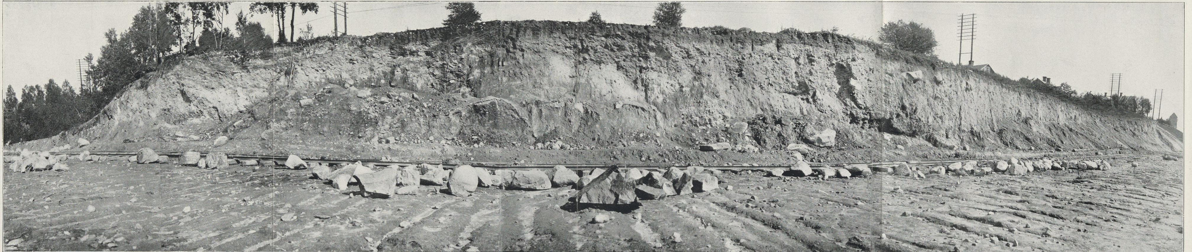
Fig. 1. Skärning i morän, i ytan svallad och ursköld, i mitten hårt packad, orörd, vilken i sin tur överlagrar skiktad och svallad sand och grus (nedtill i skärningen). Öster vid järnvägslinjen N. intill Nässjö stad.
