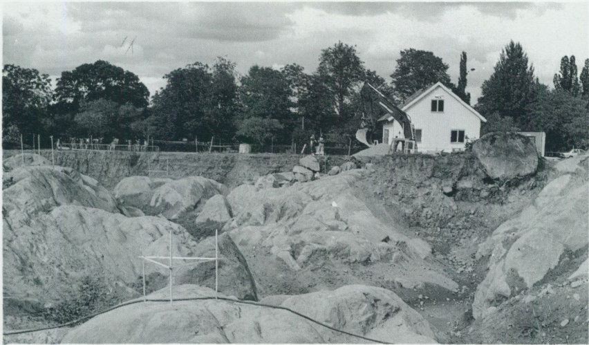
Fig. 8. Skärning som visar snabbt växlande jordartsförhållanden, 300 m öster om Bäcklösa (6a). Till vänster är det i stort sett endast glacial lera som täcker bergytan, till höger utfylls en 4 m djup kilformad sänka i bergytan av morän. Foto förf. 1989.
