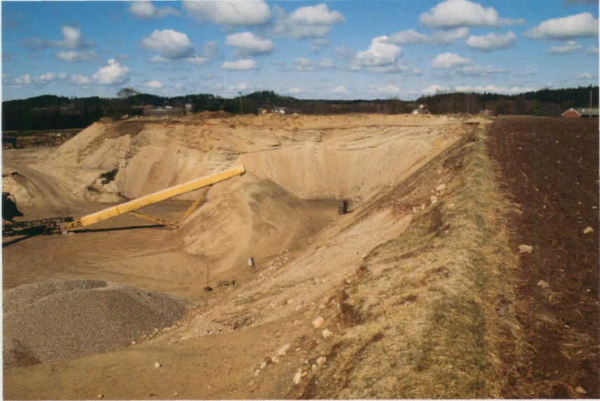
Fig. 15. Skärning i västra (distala) delen av deltat 500 m öster om Tumberg (8e). Större delen av ytan är uppodlad. Det översta lagret består av sandigt grus som överlagrar såväl horisontella som snedställda skikt av sand. Det övre lagret släpper igenom vatten och förhindrar uttorkning av den underliggande sanden. Detta gynnar rotsystemen av vissa sädeslag, främst havre. Vy mot norr. Foto förf. 1990.
