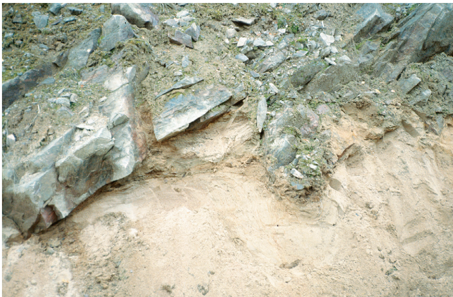
Fig. 26. Detalj av det uppspruckna blocket vid Valdaslätt (3 e) som visas i figur 25. Foto förf. 1993.
