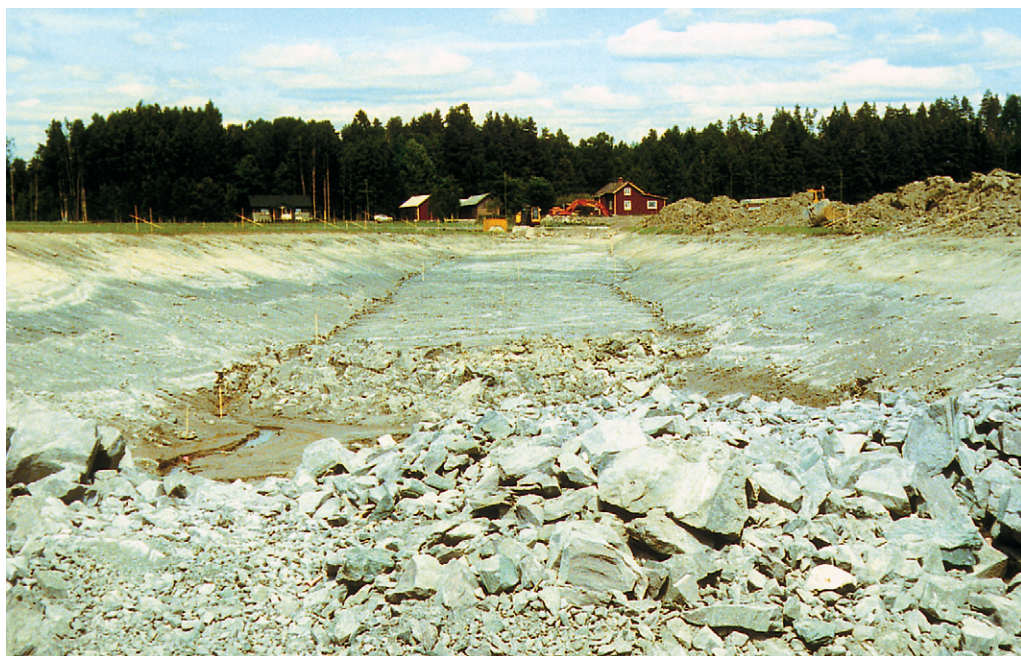
Fig. 27. Vid arbetena med planskild korsning väg–järnväg 800 m NNV Ölme k:a (6i) exponerades rödgrå glacial lera, som underlagrades av berg och överlagrades av grå postglacial lera. Foto förf. 1996.
