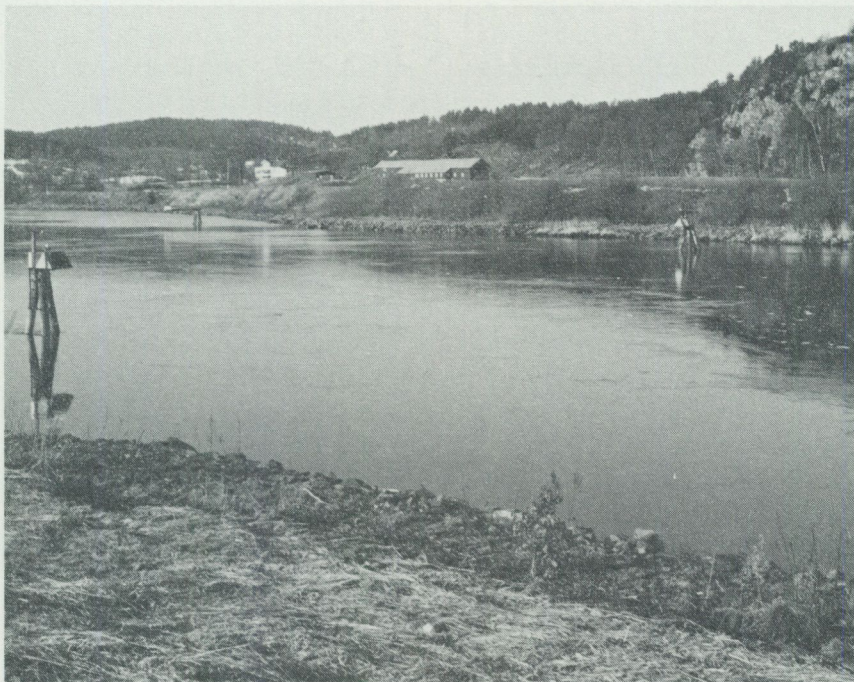
Fig. 18. För uppkomsten av initialskred i älvslänter är strand- och djuperosion av avgörande betydelse. Under 1960-talet gjordes strandskoningar med skrotsten längs Göta älv för att förhindra vågerosion. Vegetationen har senare funnit fäste och torrskorpepartier har utbildats på slänterna. Vy mot väster, 200 m nordöst om Näset (9g). Foto förf. 1984.
