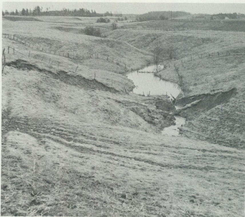
Fig. 24. På sluttningarna av ravinerna kan släntskred utlösas som – beroende på den smala V-formade dalen – kan utlösa följskred när skredmassorna träffar den motsatta sidan. Vy mot söder i ravinen 1700 m VNV om Rommele kyrka (Ii). Foto förf. 1979.
