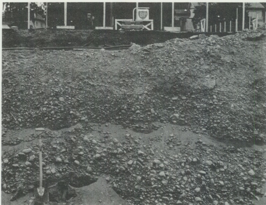
Fig. 9. Skärning i stenigt isälvsgrus vid grundgrävningen för Borås Tidnings hus, Allégatan 67, Borås (0f). Foto förf. 1977.
