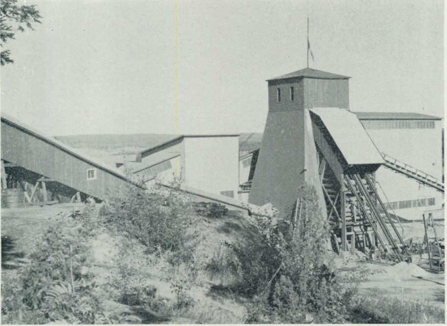
Fig. 2. Lave med lutande spårbanor för hund från stigort (i förgrunden) samt kross- och anrikningsverk, Pershytte Storgruva. Foto P. H. Lundegårdh 1968.
