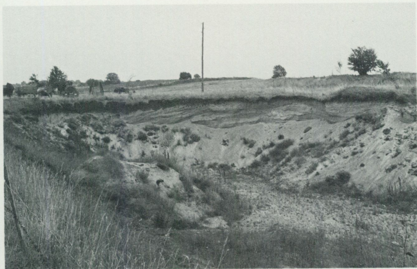
Fig. 11. Skärning i isälvsand vid Strömmeln (9h). Materialet är mycket rasbenäget och väggarna i sandtagen vid Strömmeln är nästan helt igenrasade. Foto förf. 1983.
