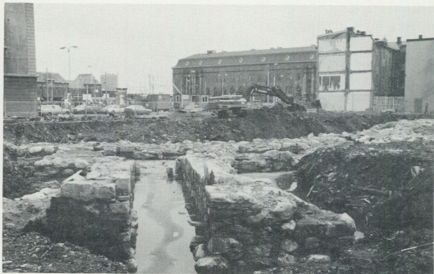
Fig. 23. I den centrala delen av Göteborg (0e) är kulturlagren flera meter mäktiga. På bilden syns resterna efter bastionen Carolus Rex, som ingår i det gamla befästningsverket (rivet 1820) längs den dåtida sträckningen av vallgraven. I bakgrunden Drottningtorget och Centralstationen. Vy mot nordost. Foto C. Fredén 1984-02-13.
