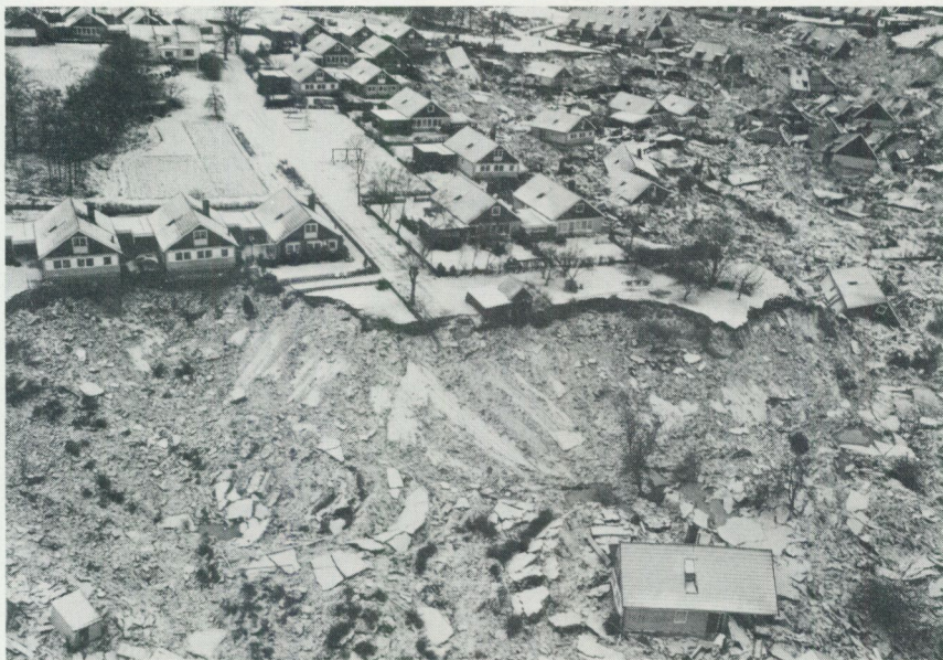
Fig. 18. Vy över Tångenområdet, se fig. 17. Lerans glidytor följer underliggande bergyta. Godkänd för publicering 1977-12-13. Foto C. Fredén 1977-12-08.
