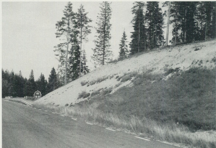
Fig. 10. Skärning i isälvsavlagring 150 m söder om Brobacken (6c). Sedimenten utgörs till allra största delen av sand med något inslag av småsten. Foto förf. 1984.
