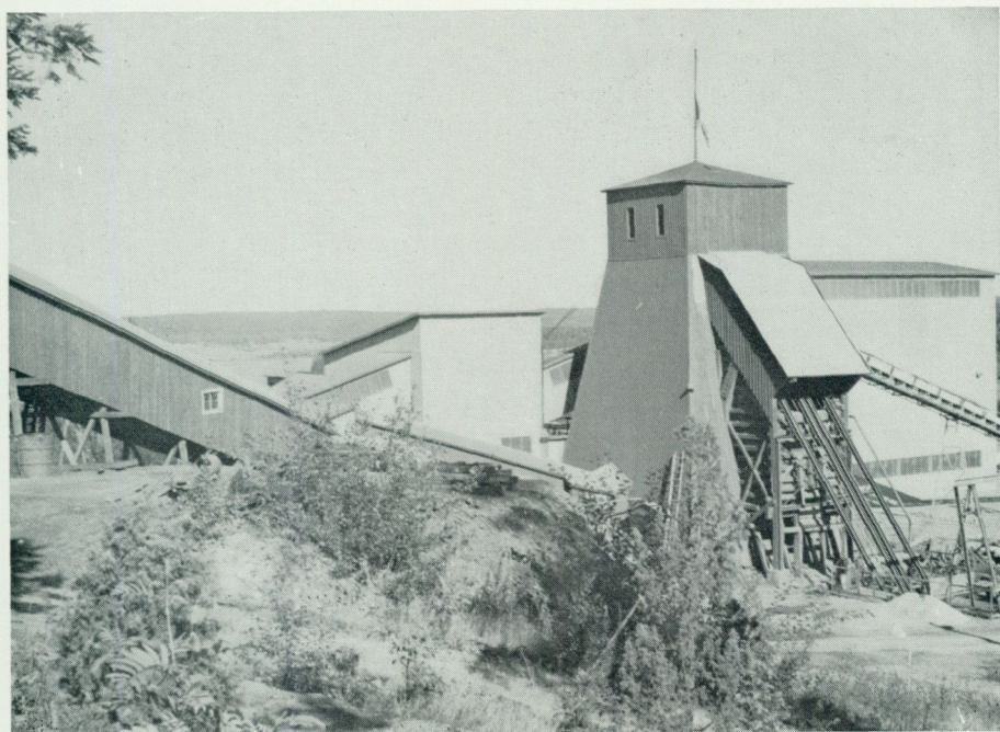
Fig. 58. Laven med lutande spårbanan för 'hund' (uppföringsvagn) från stigtort (i förgrunden) samt kross- och anrikningsverken, Pershytte Storgruva. Foto P. H. Lundegårdh 1968.
