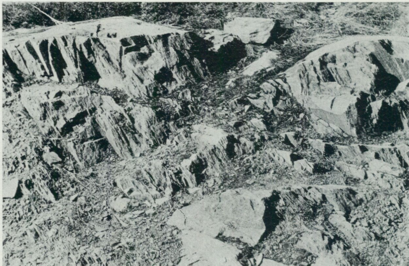
Fig. 15. Förskiffringen i leptiterna sammanfaller nära med leptiternas lagring. De glimmerklädda förskiffringsytorna utgör spaltbarhets- och avlossningsplan. Sprängd vägskäring SV om Lindhagen (5 g).
