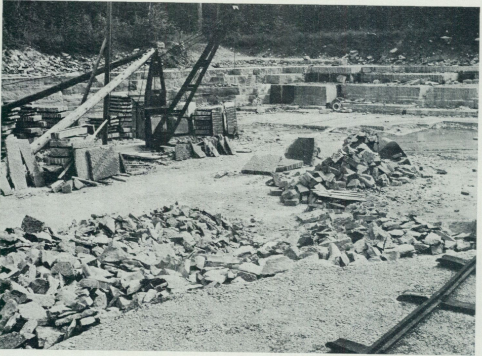
Fig. 9. Kalkstensbrott 300 m väster om Skärsätter (1 h). Foto P. H. Lundegårdh 1966.
