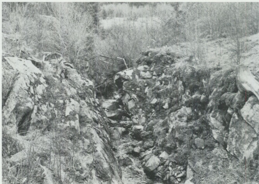
Fig. 23. Sprickzonen Lövskogen–Stenstorp. Sprickzonen, som mäter 2.5 km i längd, är ställvis blott någon enstaka meter bred. Bron över Hattabäcken vid Örlid(0c).
