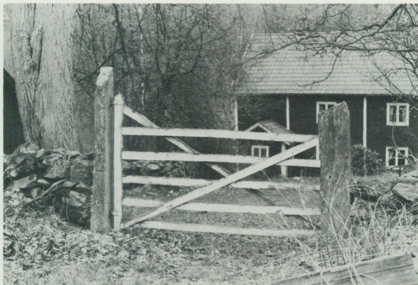
Fig. 6. Grindstolpar av starkt stänglig glimmerskiffer, s.k. ledsten. Bökestad sågmölla (6c). Foto K.-A. Kornfält.
