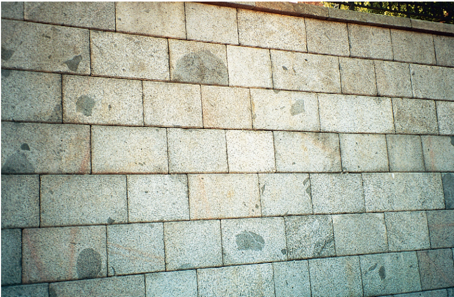
Fig. 32. Stenmur av tonalit (s.k. Uppsalagranit) med basiska inneslutningar. S:t Erikstorg, Uppsala, 7a, 663910/160245. Stenblockens höjd ca 3 dm. Stone wall made of tonalite, containing mafic inclusions.
