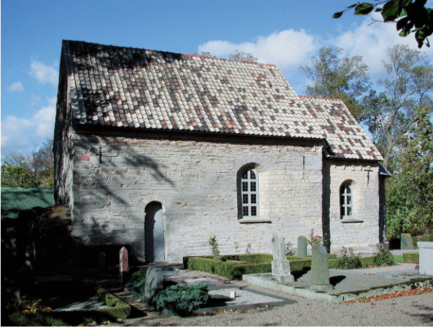
Fig. 102. Borrie kyrka uppförd i Komstadkalksten, Köpingsansten och Lyckåsmärgel (2D 0 f, 6153030/1376800). Foto Mikael Erlström.
