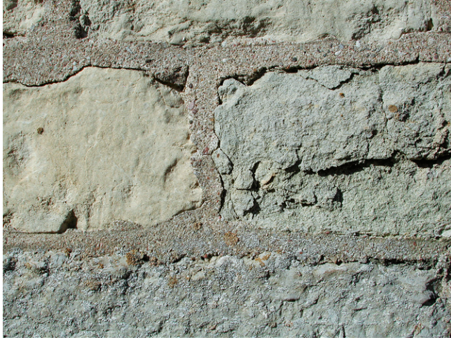
Fig. 81. Byggnadssten av Köpingsandsten (vänstra blocket) tillsammans med grågrön Lyckåsmärgel (höger) och Komstadkalksten (nederst) i Borrie kyrka (2D 0 f, 6153030/1376800). Foto Mikael Erlström.
