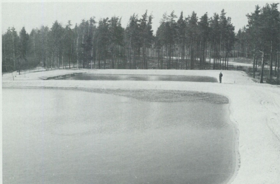
Fig. 22. Infiltrationsbassäng vid Eskilstuna vattenverk i Hyndevad (5h). Foto C.-F. Müllern.
