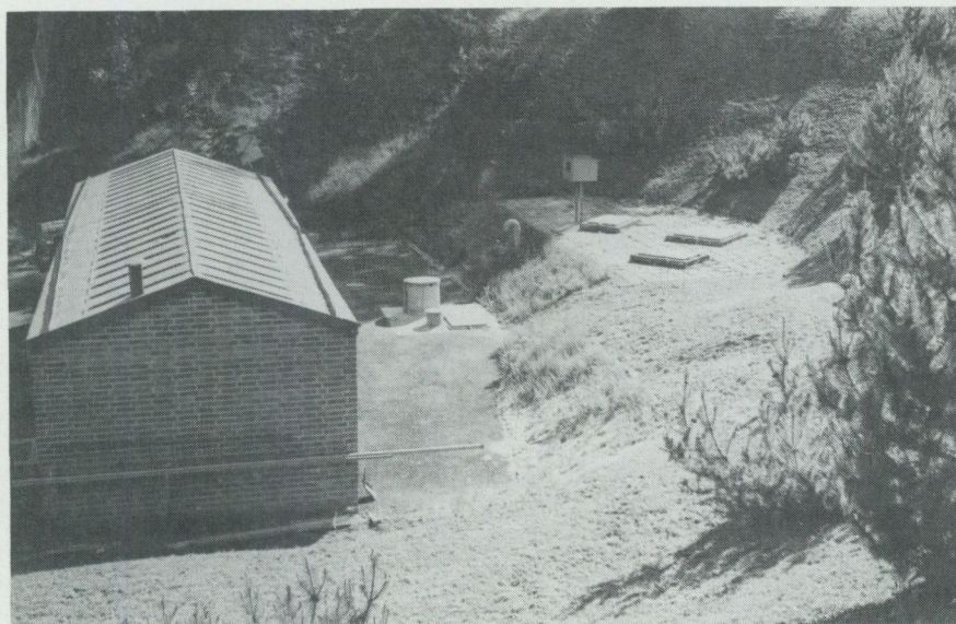
Fig. 24. Vattenverket i Kjula (7j). Foto P. Engqvist.
