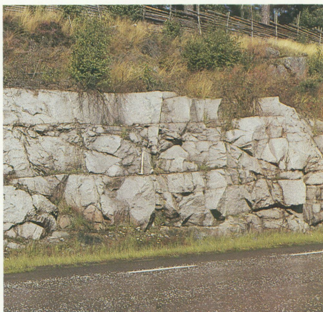
Väg 138, Växjö-Braås. Fin- till medelkornig, röd Växjögranit med välutbildade bankningsplan (horisontella spricksystem), som ofta är rikligt vattenförande. Foto B. Fogdestam.
