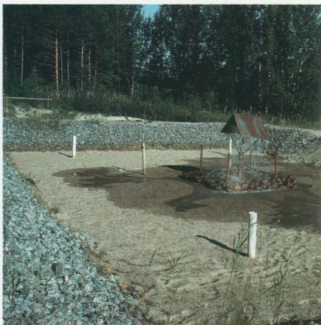
Infiltrationsdamm med luftningsanordning ingående i anläggningen för konstgjord grundvattenbildning cirka fem kilometer sydväst om Kilafors. Foto H. Söderholm.
