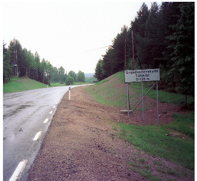
Hällefors vattentäkt, några hundra meter från vägen, är väl skyddad mot föroreningar i samband med trafiken. Skadliga vätskor från t. ex. en tankbilsolycka hindras med hjälp av tätskikt i diken från att nå grundvattnet. Jeppetorp, Hällefors kommun. Foto J. Pousette. The municipal groundwater wells at Hällefors are well protected against pollution from traffic. Hazardous fluids from e.g. an oil truck accident are prevented from reaching the groundwater with the help of sealing layers in the road ditches. Jeppetorp, Hällefors municipality.
