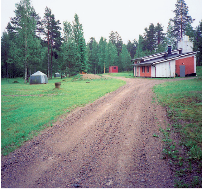
Hällefors vattenverk. Grundvatten pumpas upp ur brunnar i en isälvsavlagring vid sjön Torrvarpens norra strand. Jeppetorp, Hällefors kommun. Foto J. Pousette. The water works at Hällefors. Groundwater is pumped from wells in a glaciofluvial deposit on the northern shore of lake Torrvarpen. Jeppetorp, Hällefors municipality.
