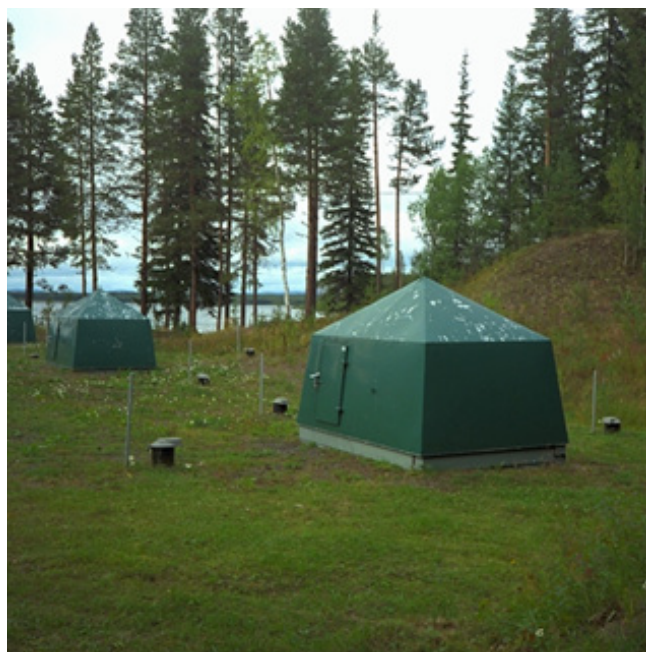
Föllinge vattenverk. Grundvattnets kvalitet förbättras genom att uppumpat vatten syresätts och återinfiltreras, den s.k. VYREDOX-metoden. Foto: J. Anderberg.
