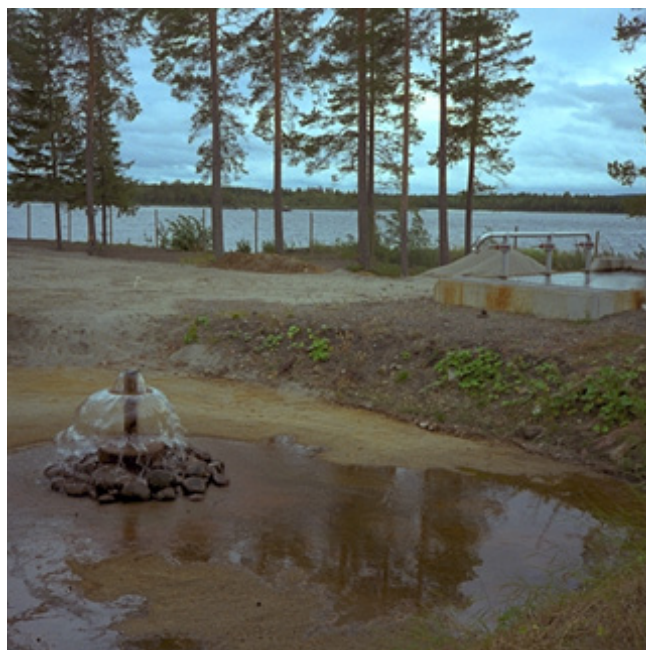
Hammerdals vattenverk. Inducerad infiltration av sjövattnet förstärker grundvattentillgången. För att förbättra vattenkvaliteten luftas och återinfiltreras grundvattnet före distribution. Foto: J. Anderberg.
