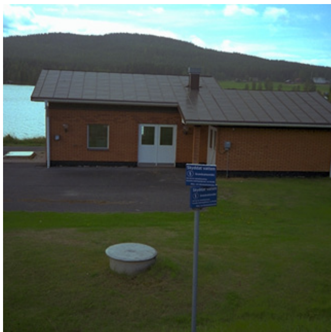
Stuguns vattenverk. Grundvatten tas ur de kvartära avlagringarna vid Indalsälvens strand. Tillgången förstärks genom inducerad infiltration av älvvattnet. Foto: J. Anderberg.
