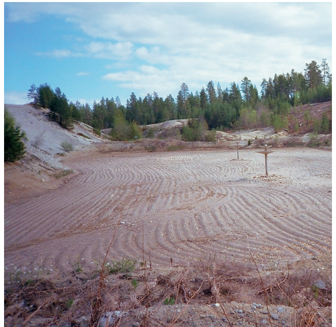
Torrlagd infiltrationsdamm i Gerdal. Dammens botten har rensats och iordningställt för ny infiltrationsperiod. Foto: Jan Pousette.
