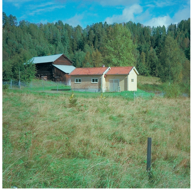
Ramsele vattenverk vid Faxälven. De djupare, vattenförande lagren täcks av finkorniga sediment och ett ytlager av sand. Flera produktionsbrunnar finns i vattentäktområdet. Foto: Jan Pousette.
