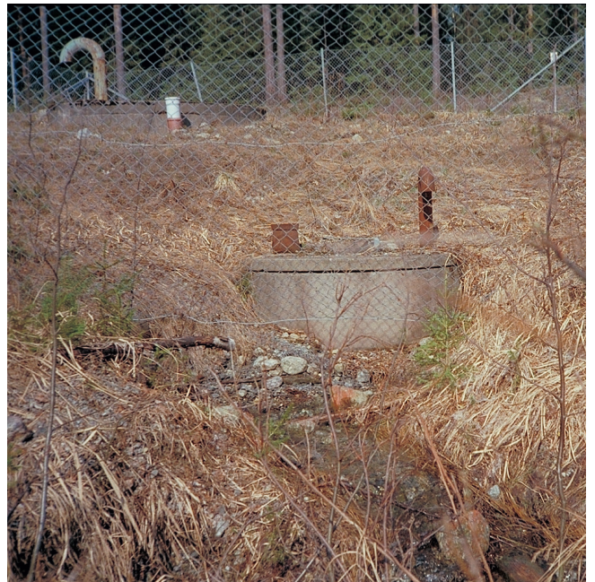
Moradals vattentäkt, Ånge. Produktionsbrunn i isälvsediment. Foto: Jan Pousette.
