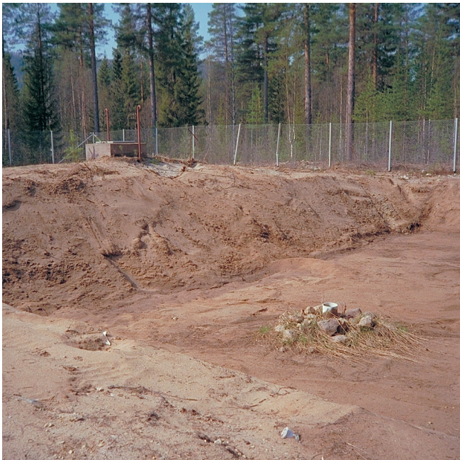
Moradals vattentäkt, Ånge. Infiltrationsdamm för konstgjord grundvattenbildning. Foto: Jan Pousette.
