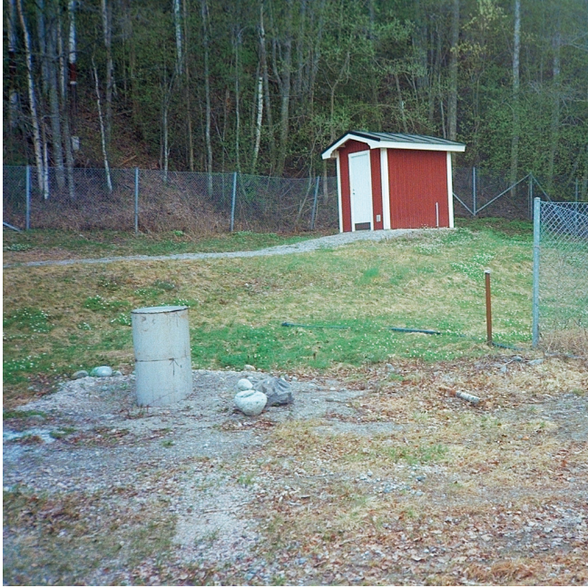
Lidens vattenverk vid Indalsälvens norra strand. Grundvattentillgången förstärks sannolikt genom inducerad infiltration av älvvatten. Foto: Jan Pousette.
