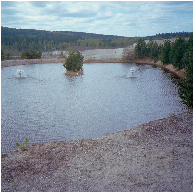
Örnsköldsviks vattenförsörjningsanläggning i Gerdal. Infiltrationsbassäng för konstgjord grundvattenbildning. Foto: Jan Pousette.
