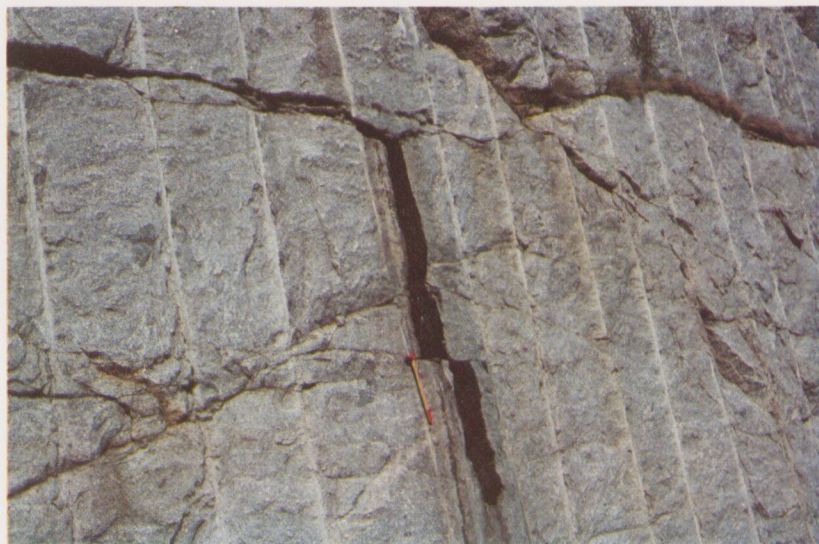
Grundvattenläckage från bankningsplan i Karlshamnsgranit. 2 km Ö Åryd. Foto B. Fogdestam. Groundwater leakage from sheet joints in Karlshamn granite. 2 km E Åryd.
