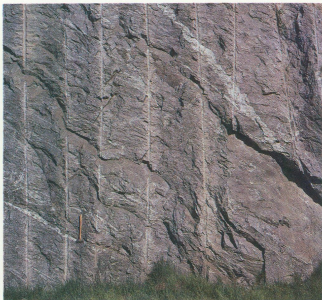
Granatådergnejs: sprickfattigt tätt parti med pegmatitgång och bevarade borrhölar. Vattengenomsläppligheten är här mycket obetydlig. Nya Dalarövägen söder om Brandbergen i Handen, Haninge kommun.
