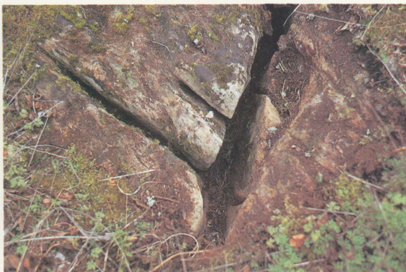
Sprickor i kristallin karbonatsten, utvidgade genom kemisk vittring (karstvittring). I sådana fall kan kalkstens- och dolomitområden vara mycket starkt vattenförande. 1 km S om Hällberga. Foto C.-F. Müllern.
