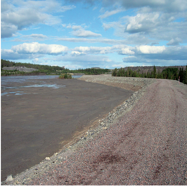
Damm för gruvavfall vid Svappavaara. Denna typ av dammbyggnader utgör en potentiell föroreningsrisk för ytvatten, grundvatten och mark. Foto: T. Aneblom.
