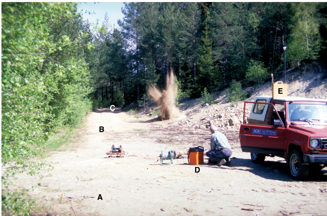
Fig. 3. Vid seismiska mätningar detoneras en mindre dynamitladdning och ljudvågorna som fortplantar sig i marken registreras av geofoner vid A, B och C. D är en seismograf som ritat upp och lagrar kurvor för ljudvågornas utbredning. E är en GPS-mottagare för positionering. Foto: C.-F. Müllern.
