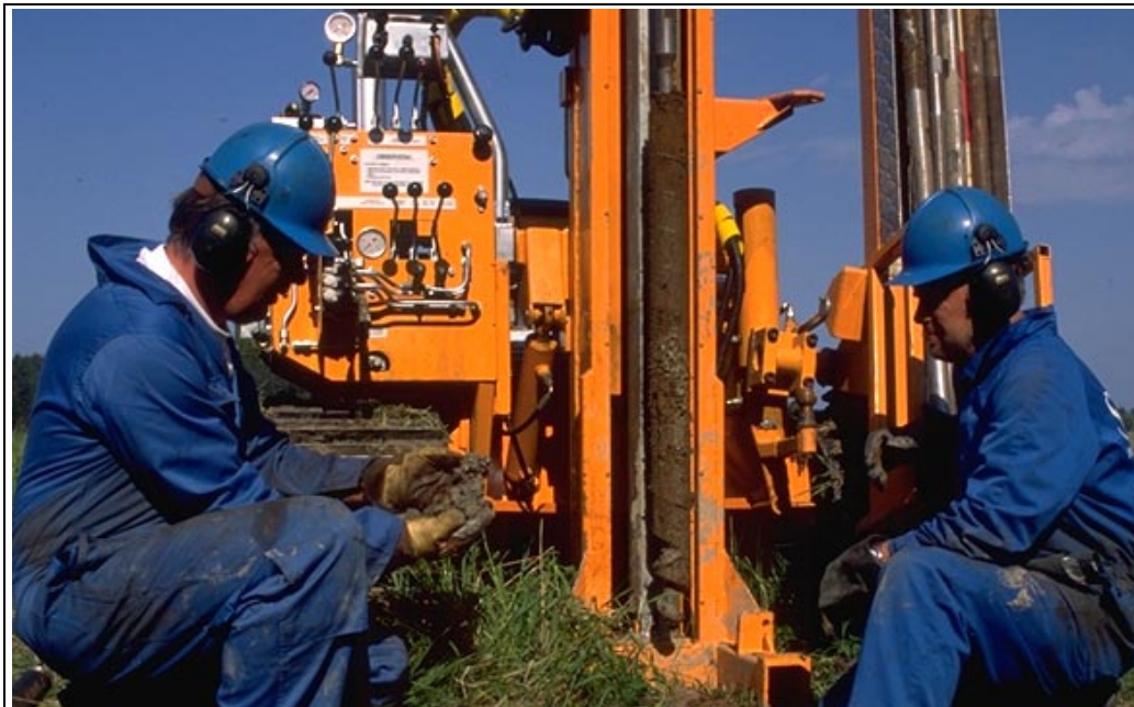
Fig. 2.f. Undersökning med borrhandsvagn av de övre, leriga jordlagren. Foto C.F. Müllern 1995.
