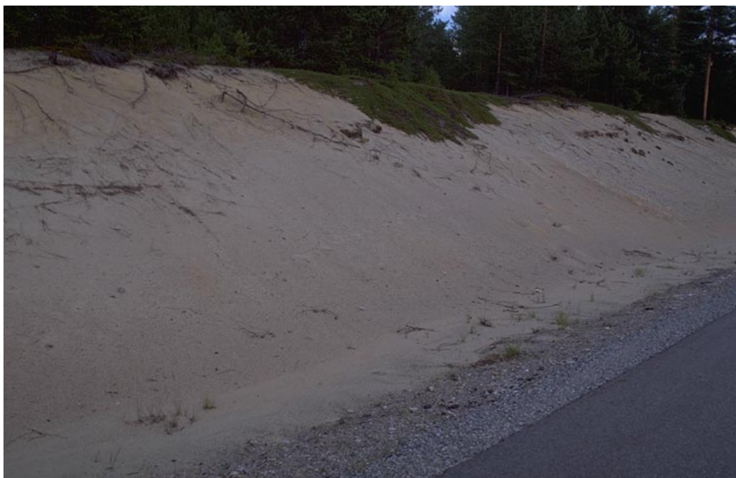
Fig. 2.b. Skärning i dynavlagring för länsväg 301 vid Mohed. Dynbildningen är av vinden avsatt sediment, främst grovmo, som är finkornigare än sand. Genomströmningshastigheten för t ex en förorening är därmed också lägre än i sanden. Under dynavlagringen förekommer antingen isälvssediment (sand och grus) eller morän. Foto H. Söderholm 1997.
