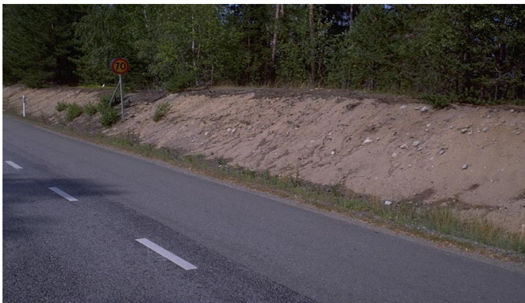
Fig. 2.a. Skärning i övervägande sand i Söderalaåsen för länsväg 301 vid Kinsta. Vid t ex en tankbilsolycka som medför läckage av innehållet infiltrerar detta direkt i sanden och når grundvattnet med en hastighet av någon meter per tim. I de grusiga lagren är hastigheten ännu högre, vanligen 10 meter per tim. Foto H. Söderholm 1997.
