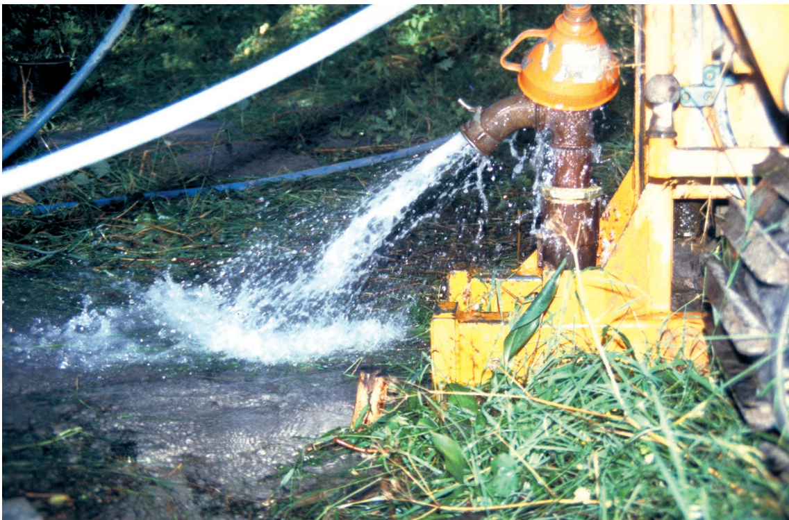
Fig. 2.6. Rensning är en viktig del i samband med etablering av observationsrör och rörbrunnar. Härvid spolas det finkorniga jordmaterialet upp till ytan och ett filter byggs upp omkring rörspetsen eller brunnens filterdel. Efter rörrensningen företas i förekommande fall propumpning i röret eller brunnen. Foto: Carl-Fredrik Müllern 1997.
