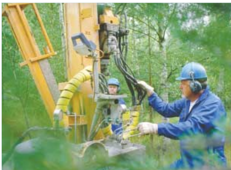
Borring för grundvattenundersökning. Foto: A. Damberg.
