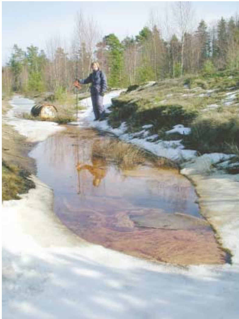
Ämariprojektet. Förenklad sanering av det mest förorenade området genom nya och fördjupade diken kring området. Dikena har kopplats ihop vid en oljeavskiljare och det renade vattnet leds vidare från området i befintliga dräneringsdiken. Foto: B. Thunholm.
