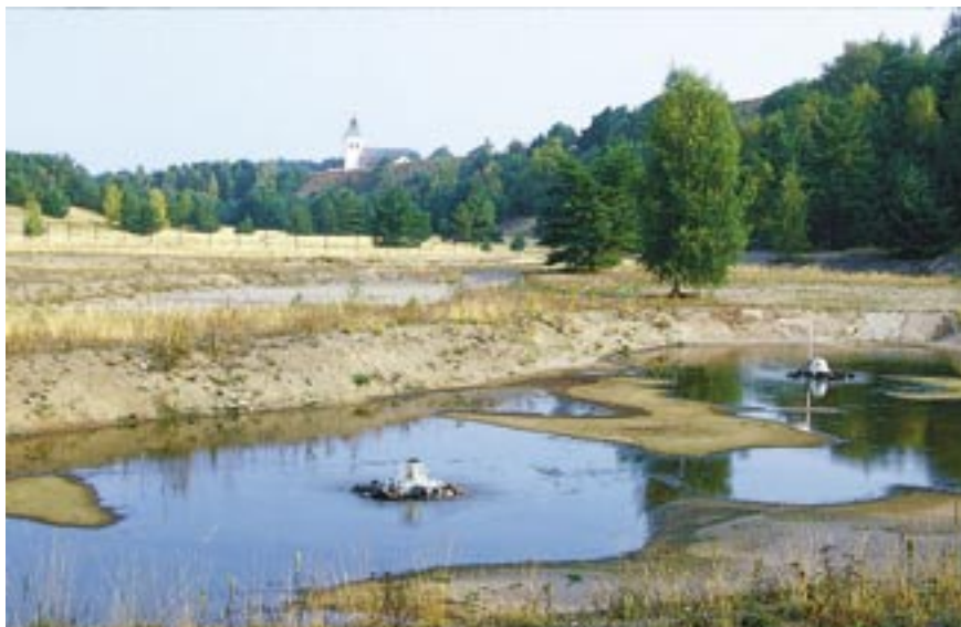
Infiltrationsdammar för råvatten i nedlagt grustag. Fjärås bräcka, Halland. Foto: Anders Damberg.
