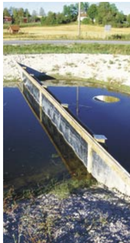
Fångdamm för vattenföreningar från väg, för skydd av grundvatten. Ekers by, nordväst om Örebro. Foto: Anders Damberg.
