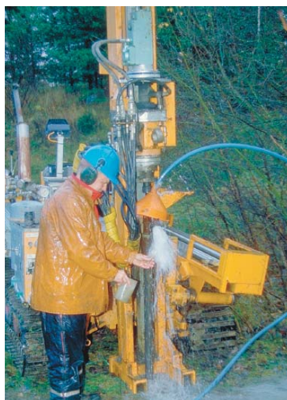
Undersökningsborrning för ny kommunal vattentäkt i Strängnäs. Foto: Carl-Fredrik Müllern.
